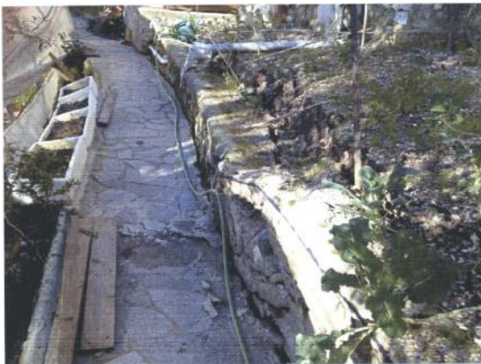
eseguiti interventi: 20 micropali cordolati in testa e 4 barre dywidag
