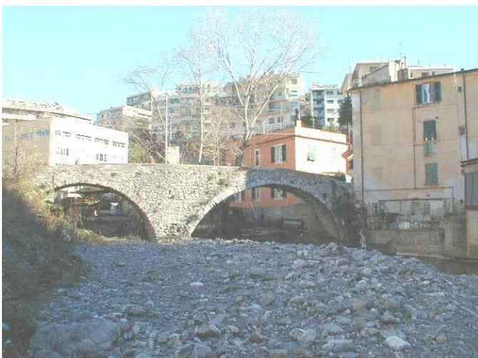
*Fig. 2.6.1.3.12 - Ponte romano: il ponte romano è a due arcate e crea un notevole ostacolo al deflusso. A valle del ponte si è determinato un deposito considerevole di materiale.*
