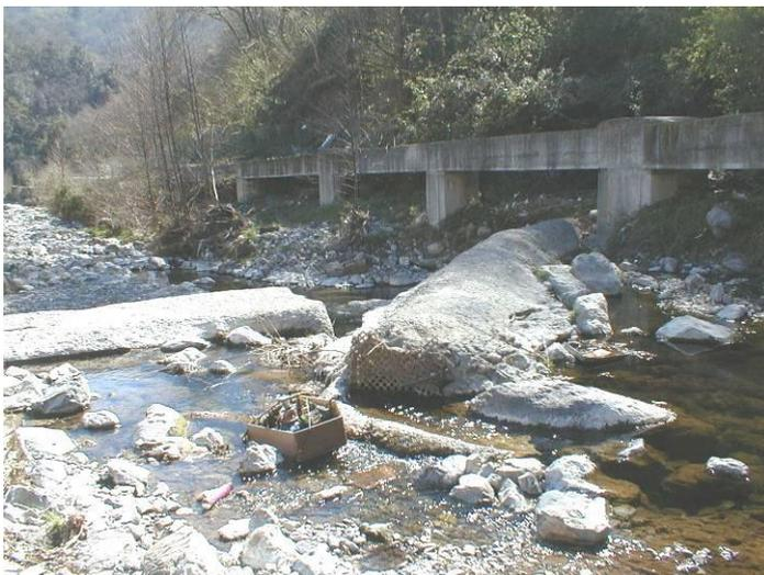
*Fig. 2.6.1.1.12 - Briglia 33 vista da monte: è stata realizzata anche una derivazione d'acqua. Si vede in sponda destra la condotta fognaria.*
