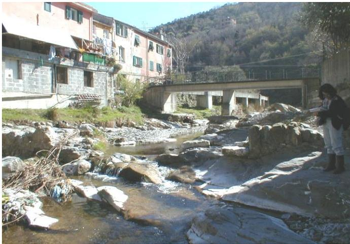
*Fig. 2.6.1.1.26 - Ponte 49.5 vista da valle: la briglia a valle del ponte è danneggiata. Esempio di tratto con alveo in roccia.*
