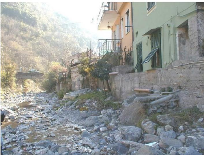
*Fig. 2.6.1.1.7 - Sponda destra a monte del ponte per Premanico: casa con finestre e porticato in alveo. Si può notare anche il deposito.*
