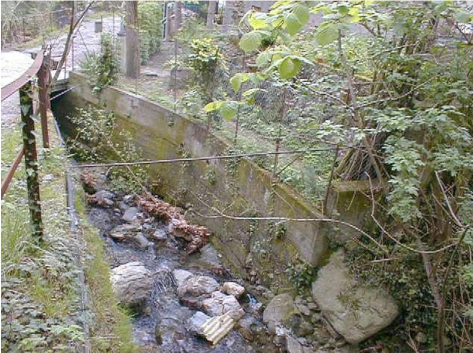
*Fig. 2.6.2.1.8 – Pos.8: confluenza del rio Ciapon con il rio Mezzano, vista da monte. Si noti il restringimento ad imbuto in corrispondenza della copertura che copre la confluenza.*
