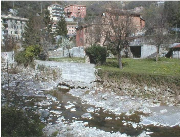
*Fig. 2.6.1.1.15 - Sponda sinistra a valle della briglia 33: il muro in cls si interrompe probabilmente in seguito ad un crollo.*
