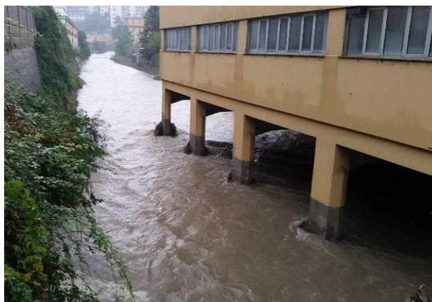
*Fig. 2.6.1.3.16 – Ex Sutter: l'edificio, attualmente Facoltà di Farmacia, restringe per metà lo spazio a disposizione del torrente; inoltre crea una grave condizione di rischio a causa dell'utilizzo della struttura come sede universitaria.*
