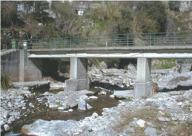
*Fig. 2.6.1.1.29 - Ponte 55.5:, vista da valle. Segni di erosione al piede delle pile.*
