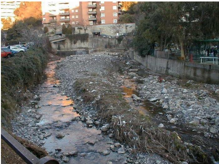
*Fig. 2.6.1.3.3 - Briglia 123 vista da valle: si può notare l'abbondante deposito a valle della briglia.*
