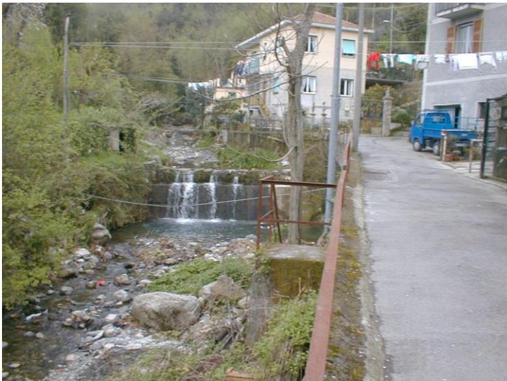
*Fig. 2.6.2.1.6 – Serie di briglie in corrispondenza della fine della strada carrabile che costeggia l'alveo, poco a monte della confluenza con i rii Mezzano e Ciapon (pos. 6).*
