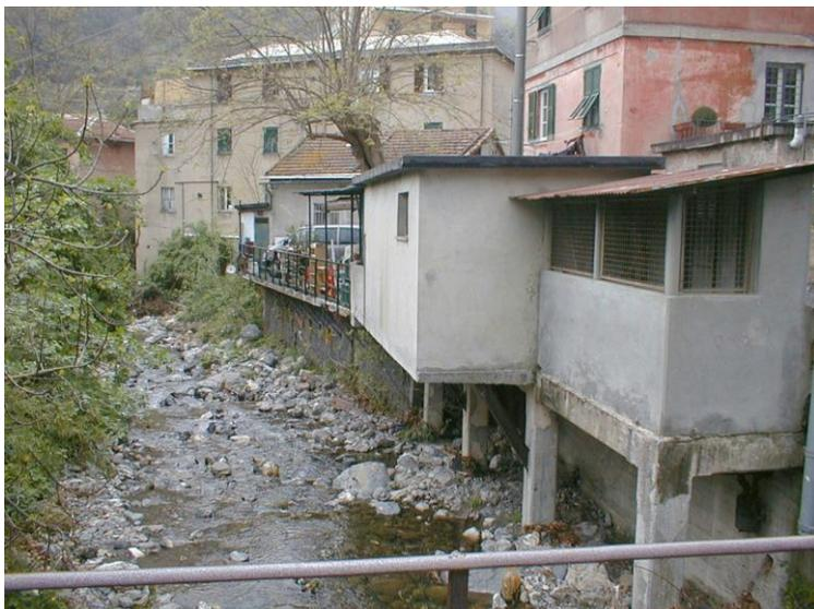
*Fig. 2.6.2.1.3 –Pos. 1, tratto terminale del rio Pomà, poco a monte della confluenza con lo Sturla . Si notino i pilastri degli edifici fondati in alveo.*
