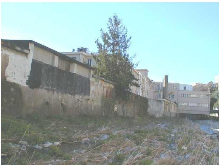
*Fig. 2.6.1.3.15 - Sponda sinistra a monte della Sutter. Gli argini sono discontinui in quanto sono costituiti da muri perimetrali di vari edifici.*
