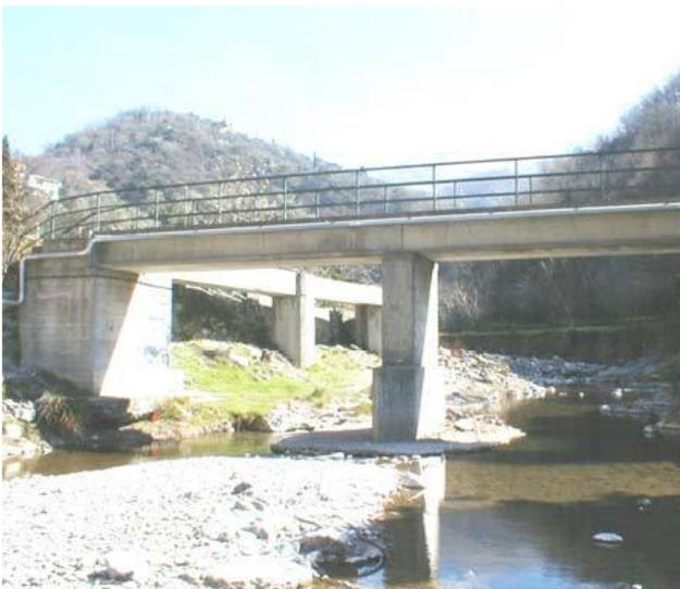
*Fig.2.6.1.1.20 - Ponte 41.5 visto da valle: il ponte, un tempo con campata a volta, è stato ricostruito con una pila e nelle recenti alluvioni è stato ostruito da alberi e lamiere, provocando l'allagamento delle case adiacenti.*
