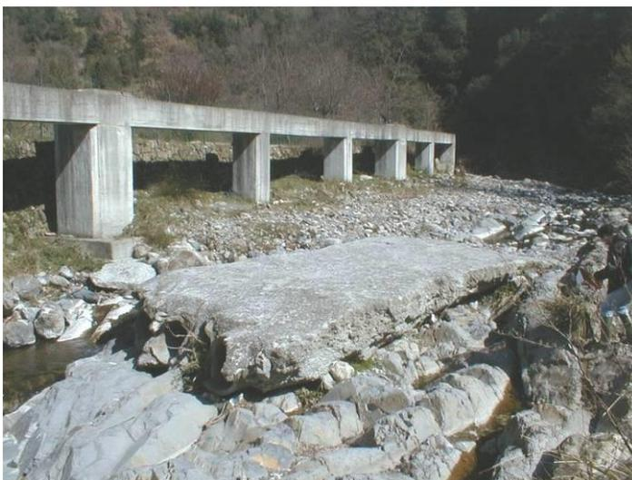
*Fig. 2.6.1.1.17 - Lastra in calcestruzzo, residuo delle opere di servizio realizzate in occasione della costruzione della fognatura.*
