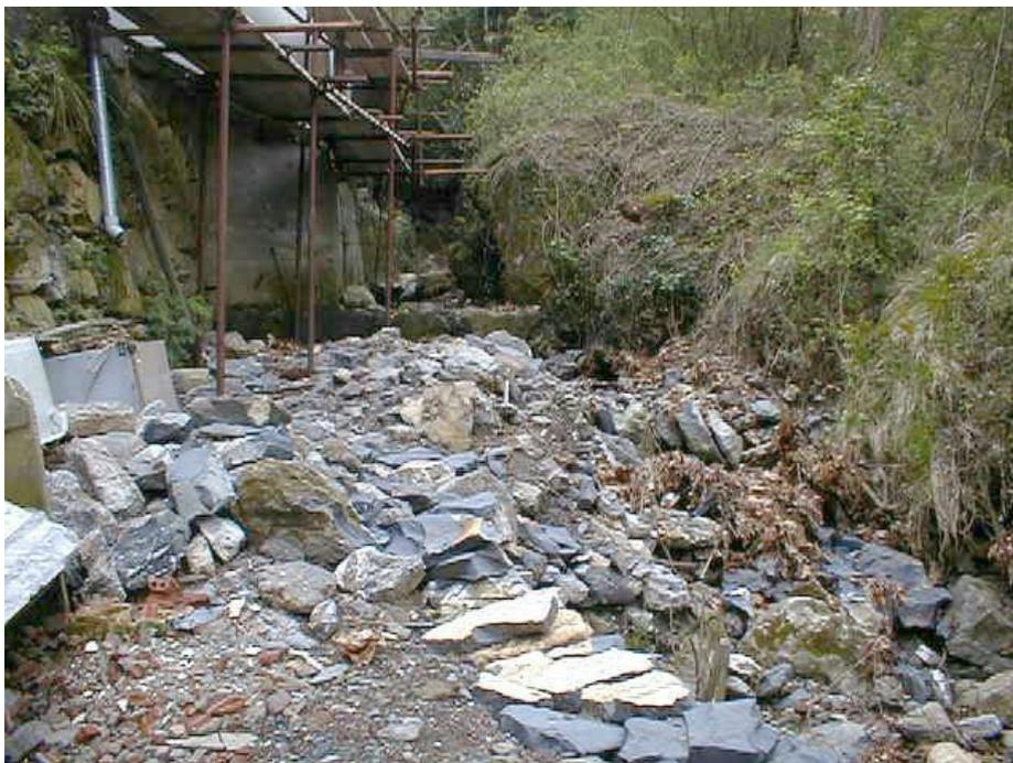
*Fig. 2.6.2.1.9 – Pos. 7: Rio Mezzano a monte della confluenza con il rio Ciapon. Il torrente risulta ostruito da ammassi rocciosi, forse derivati da lavori in svolgimento.*
