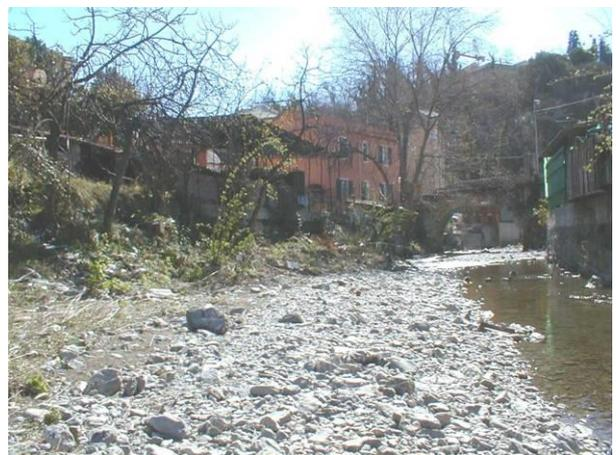
*Foto 2.6.1.3.11 - Sponda sinistra a monte del ponte romano, le case sono a bassa quota rispetto l'alveo, non protette da argini.*
