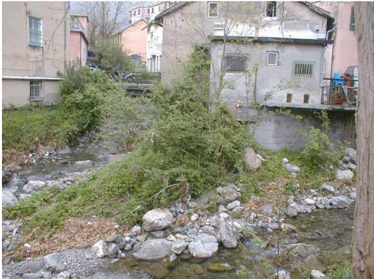
*Fig. 2.6.2.1.2 – Immissione del rio Pomà nello Sturla all'altezza di S. Desiderio. E' evidente l'intrusione dell'edificio nella confluenza.*
