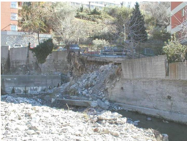
*Fig. 2.6.1.3.4 - Crollo del muro di contenimento di via Campanule, presso la briglia 123.*
