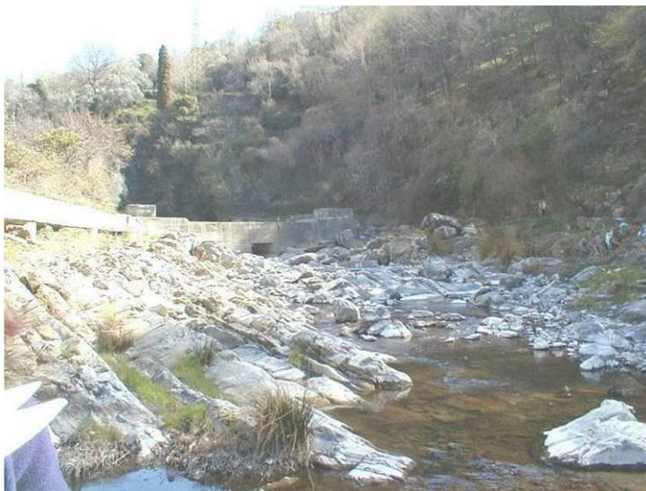
*Fig. 2.6.1.1.21 - Briglia 46, realizzata per l'attraversamento fognario, vista da valle. Si vede un cumulo di frana di massi di diametro di circa 1 m.*
