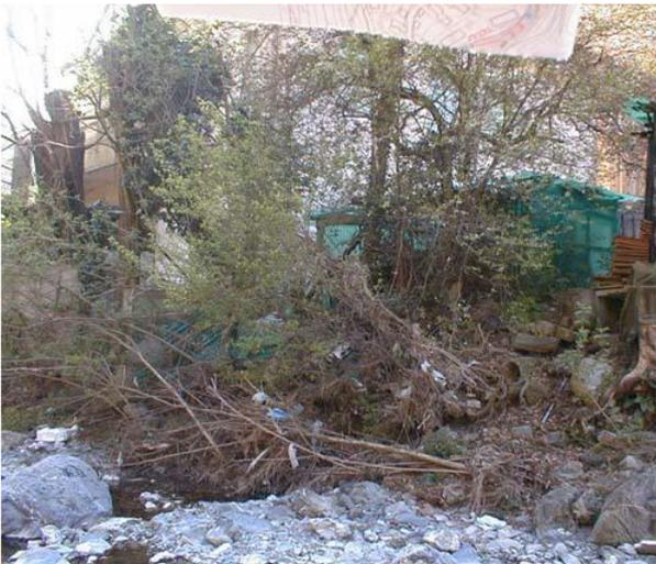
*Fig. 2.6.1.1.6 - Sponda destra a monte del ponte per Premanico (sezione 9): per una quindicina di metri l'argine è assente.*
