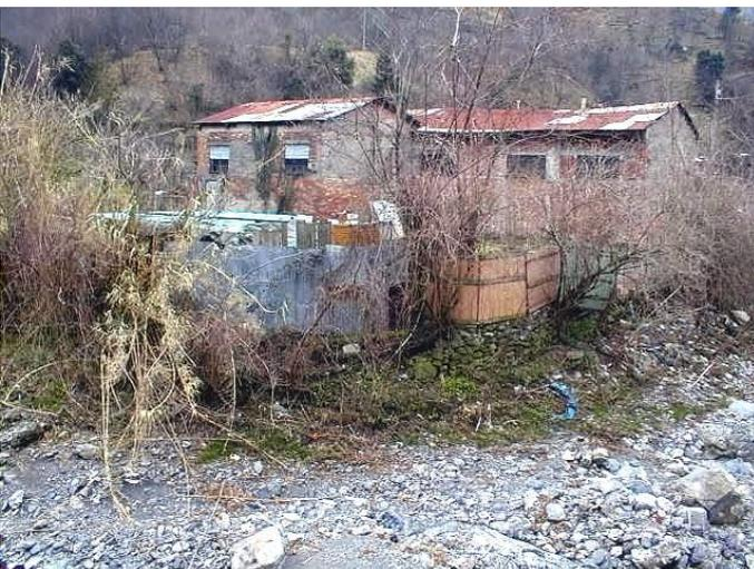
*Fig. 2.6.1.1.10 - Sponda sinistra a monte del ponte 21.5: le case non sono protette da argini.*
