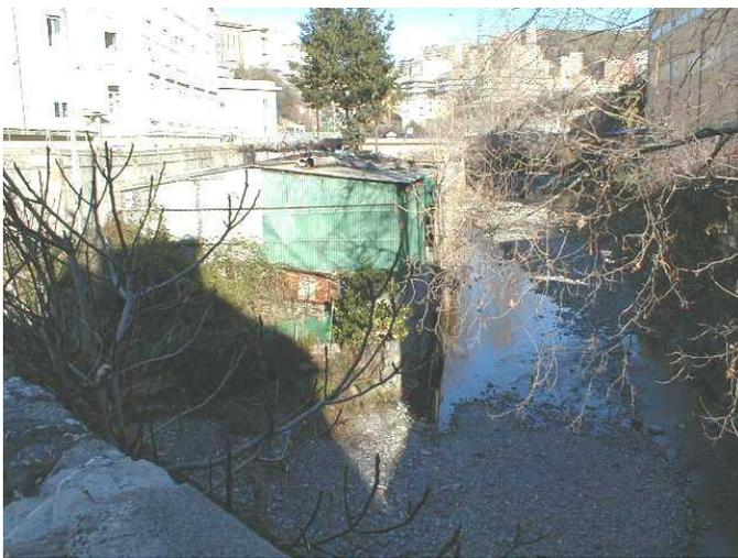
*Fig. 2.6.1.3.10 - A monte del ponte romano: si vede la baracca che provoca il restringimento della sezione subito a monte del ponte.*
