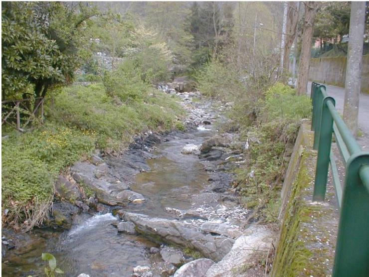
*Fig. 2.6.2.1.5 – Rio Pomà, nel tratto tra le posizioni 2 e 3, a valle di un attraversamento di servizio di una casa. Si noti la natura rocciosa dell'alveo e, sul fondo, la briglia in massi.*
