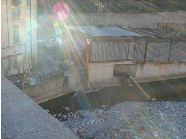
*Fig. 2.6.1.3.13 - A valle del ponte romano, in sinistra, l'argine si abbassa in prossimità di un'officina, frequentemente inondata. E' visibile anche lo sbocco del rio Penego.*
