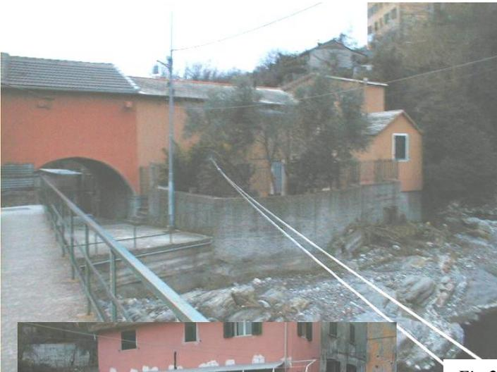
*Fig. 2.6.1.1.24 – Ponte 49.5: in sponda sinistra l'argine si abbassa in corrispondenza di una strada.*
