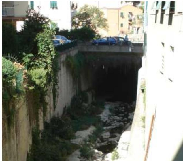
Figura 3.23 Imbocco della copertura di Largo Merlo.
