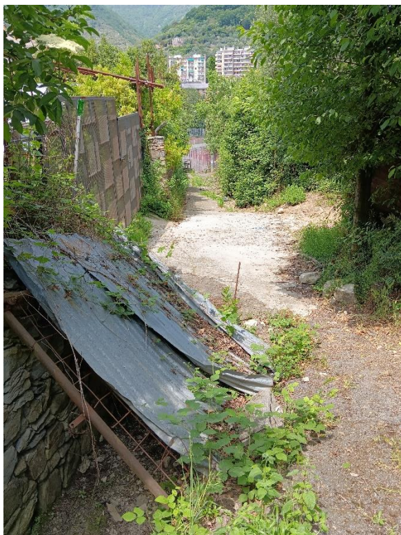
Figura 2-3 - Rio Villa Castagna - imbocco tratto tombinato di monte
