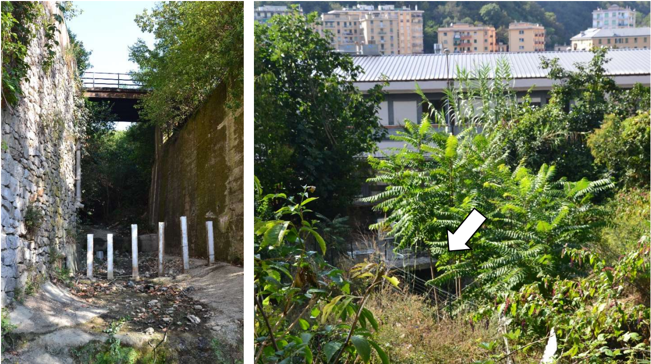
Figura 106 – Briglia selettiva sul rio Sciorba a monte della tombinatura (sx); imbocco della tombinatura (dx).
