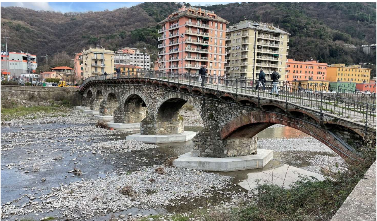
Figura 10 – Ponte Carrega visto da monte.
