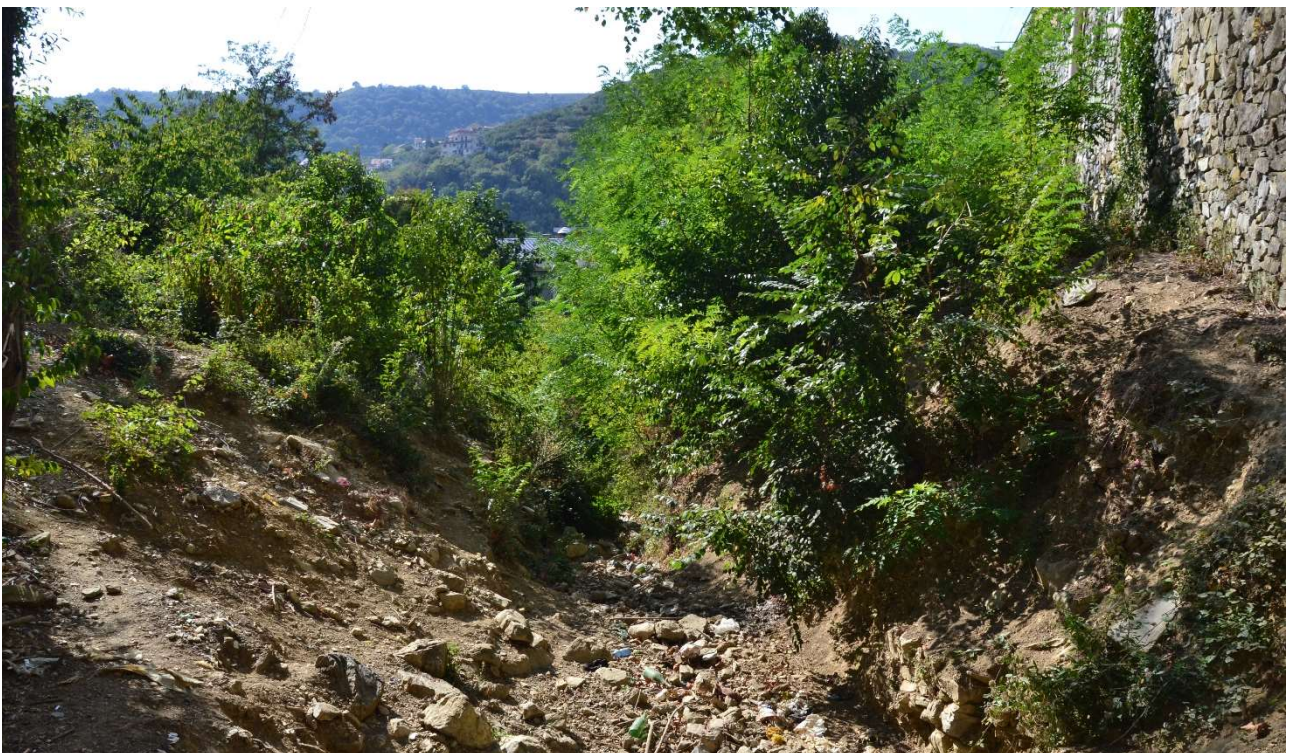
Figura 105 – Sezione del rio Sciorba poco a monte dell'imbocco della tominatura, a valle della passerella pedonale.
