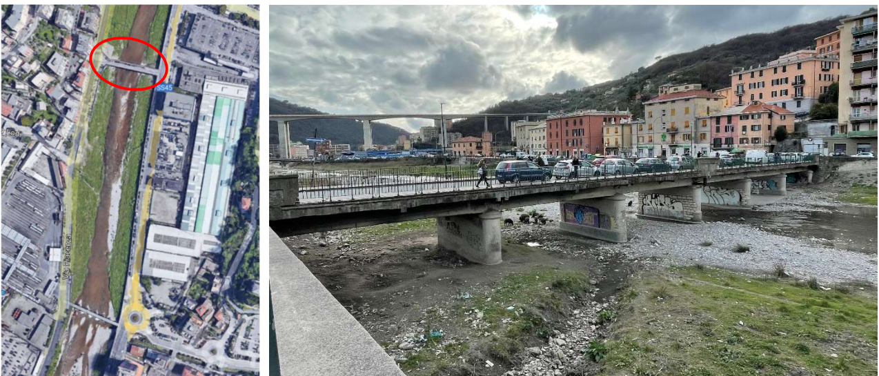
Figura 9 – Ponte Guglielmetti visto da monte.
