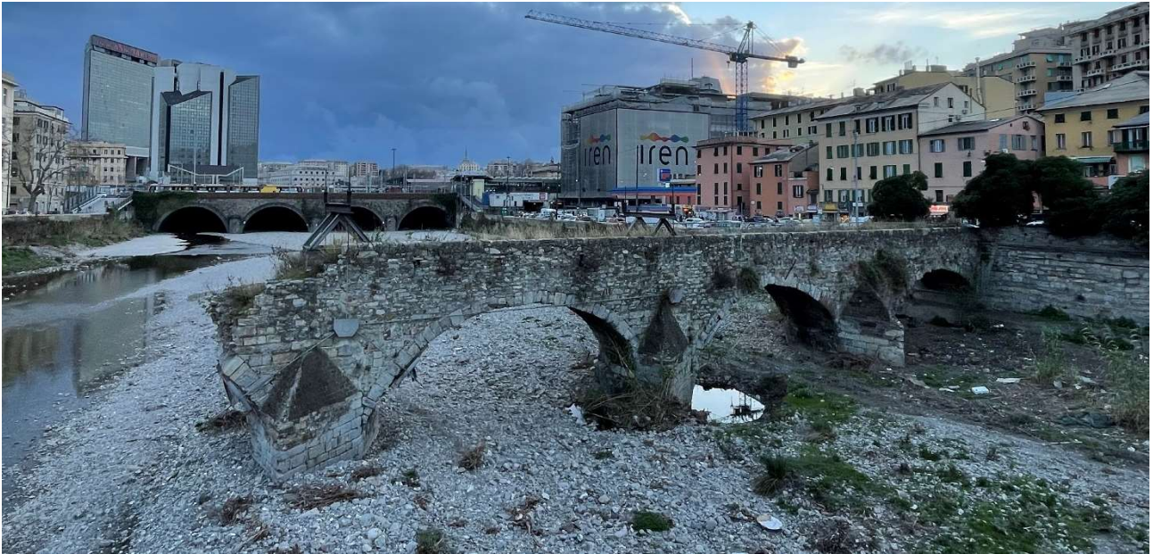
Figura 27 – Resti di passerella storica (ponte Sant'Agata) a monte della tombinatura terminale.
