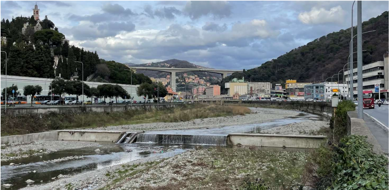
Figura 15 – Soglia di fondo in corrispondenza del cimitero.
