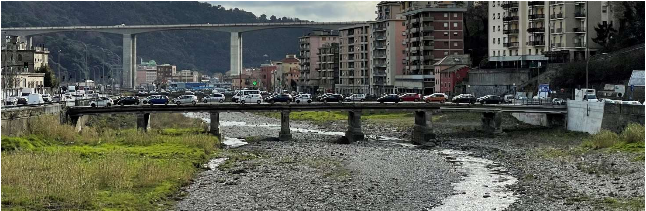
Figura 8 – Ponte Feritore visto da monte.
