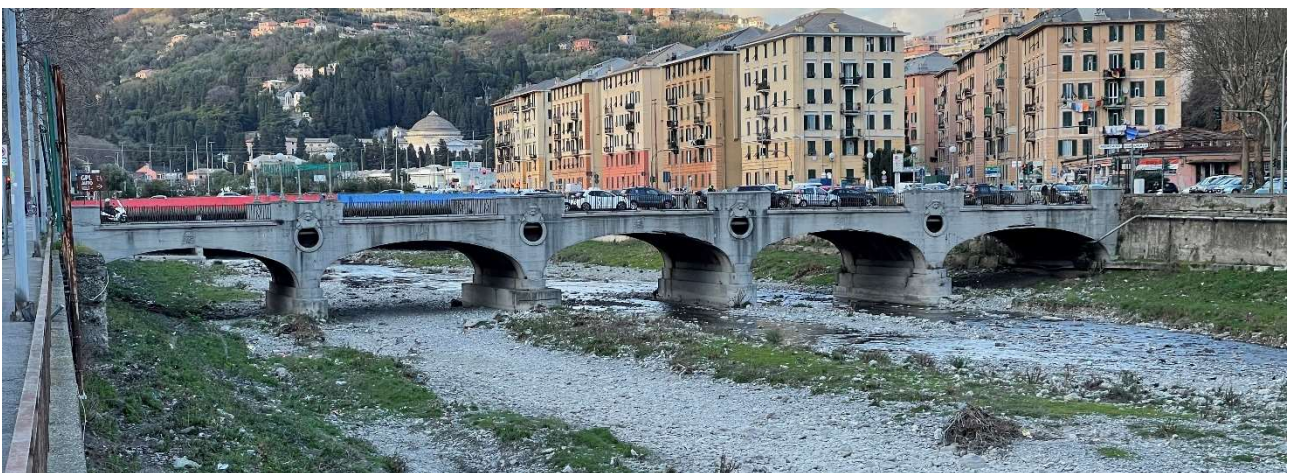
Figura 19 – Ponte Campanella (vista da valle).
