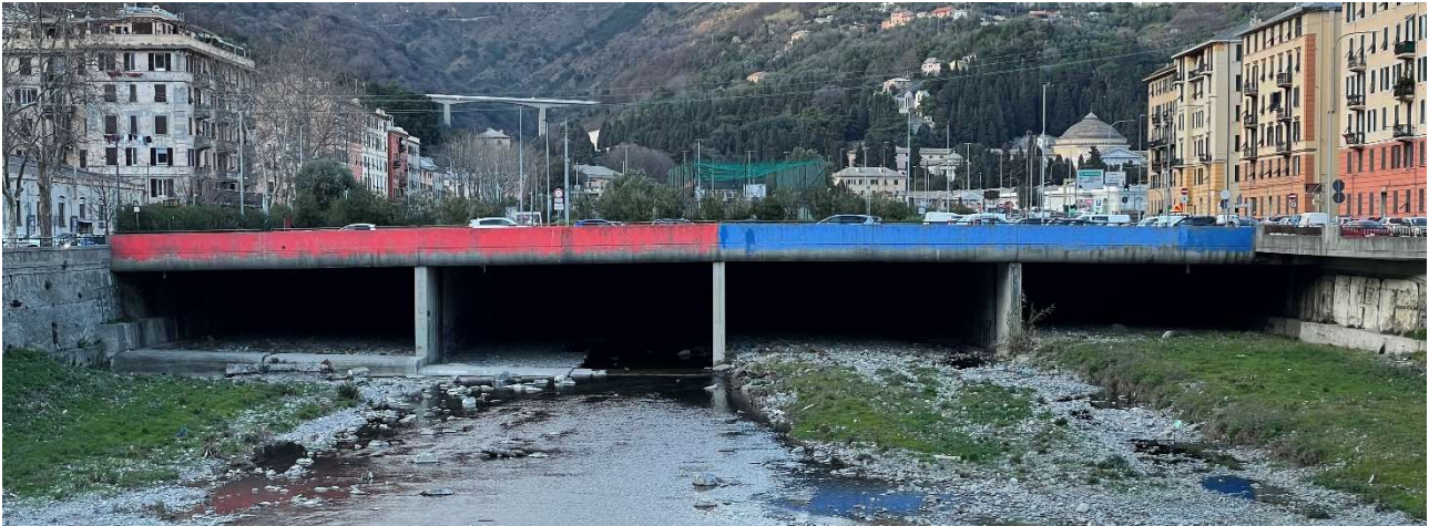
Figura 18 – Sbocco della copertura Staglieno (vista da valle).
