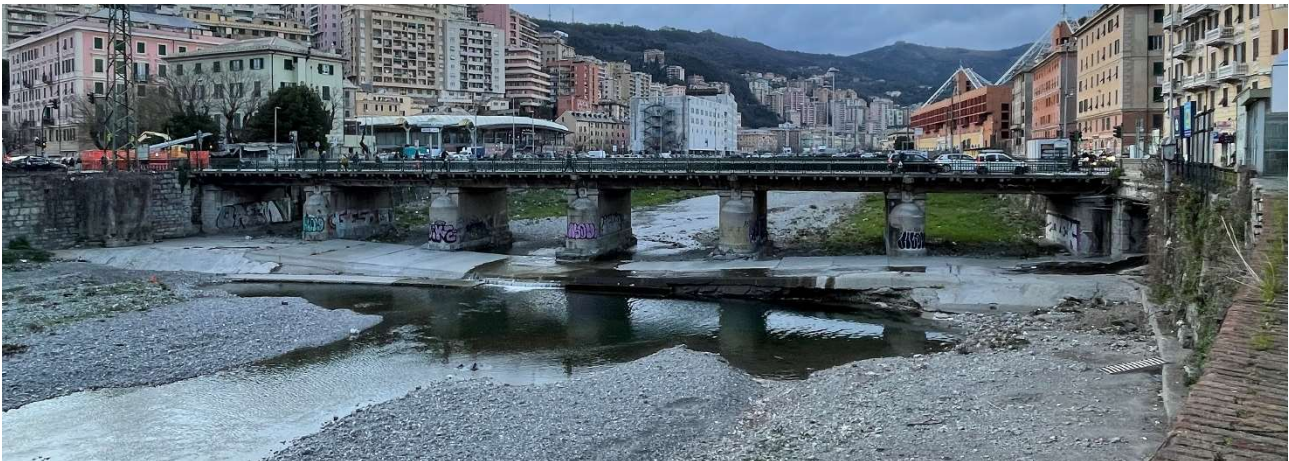
Figura 23 – Ponte Serra visto da valle. In sponda sinistra si ha la confluenza della tombinatura del rio Fereggiano.
