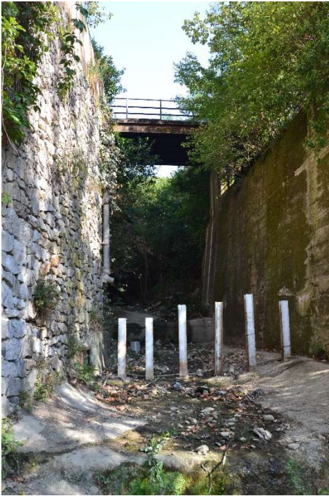
Figura 50 – Briglia selettiva sul rio Sciorba a monte della tombinata (sx); imbocco della tombinata (dx).
