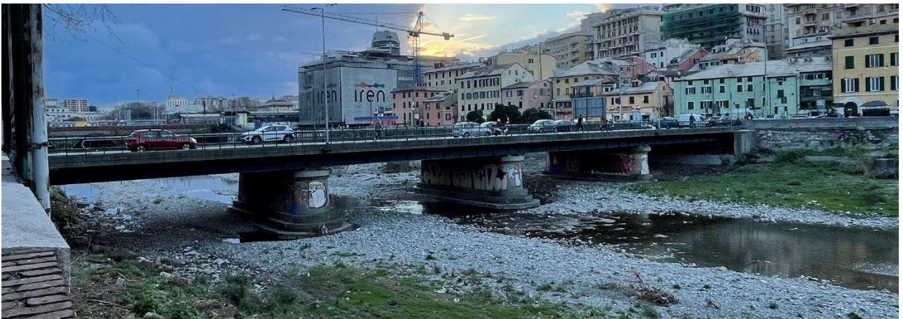
Figura 25 – Ponte Castelfidardo visto da monte.
