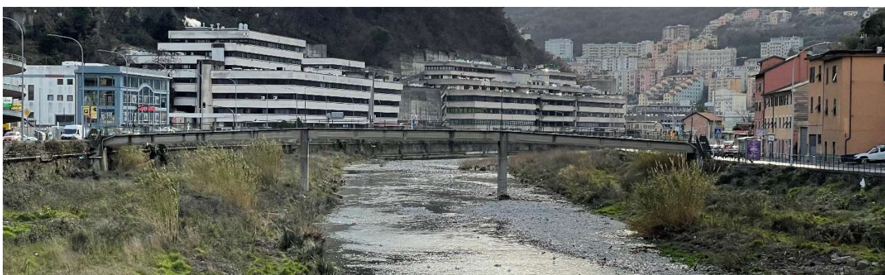
Figura 14 – Passerella pedonale presso via delle Gavette vista da monte.
