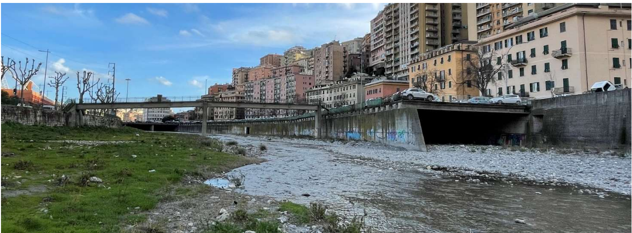
Figura 21 – Passerella pedonale all'altezza di via del Mirto (vista da monte). Sulla destra l'imbocco della canna di destra della tombinatura di Marassi.
