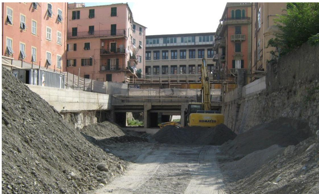
Figura 4.31 Particolare del muro di sponda realizzato su entrambi i lati nel tratto di Torrente Chiaravagna oggetto dei lavori di demolizione degli edifici nel corso del 2013.
