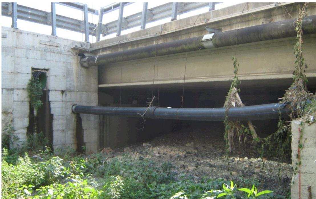
Figura 4.34 Sezione di imbocco dello scolmatore, in corrispondenza del ponte di Via Albareto, nella configurazione attuale.
