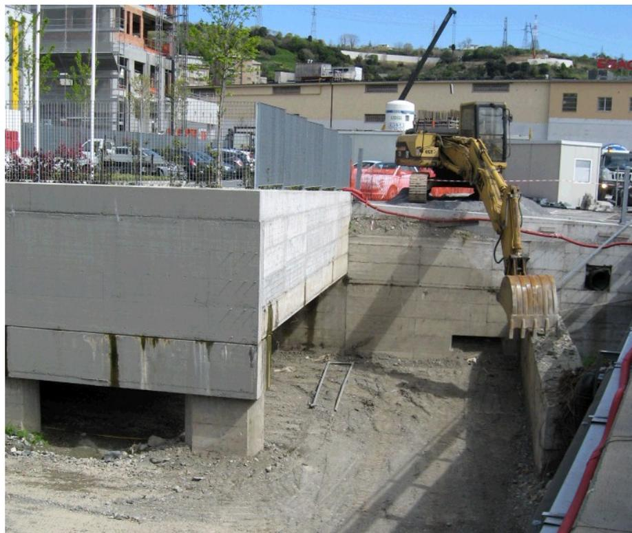
Figura 4.33 Lavori di demolizione, eseguiti nel corso del 2011, del muro presente in corrispondenza della sezione di imbocco dello scolmatore realizzato in corrispondenza dei ponti di Via Albareto e dei binari ferroviari.
