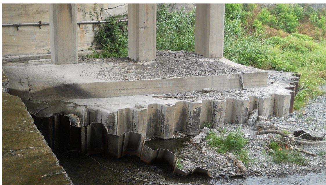
Sezione CHI 28 – particolare pila del ponte autostradale A10
