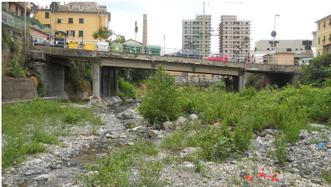
Sezione CHI 34 – vista da monte
