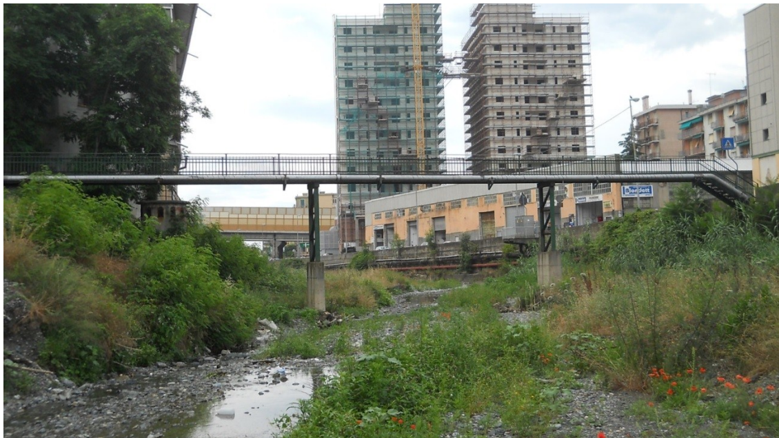
Sezione CHI 32 – vista da monte
