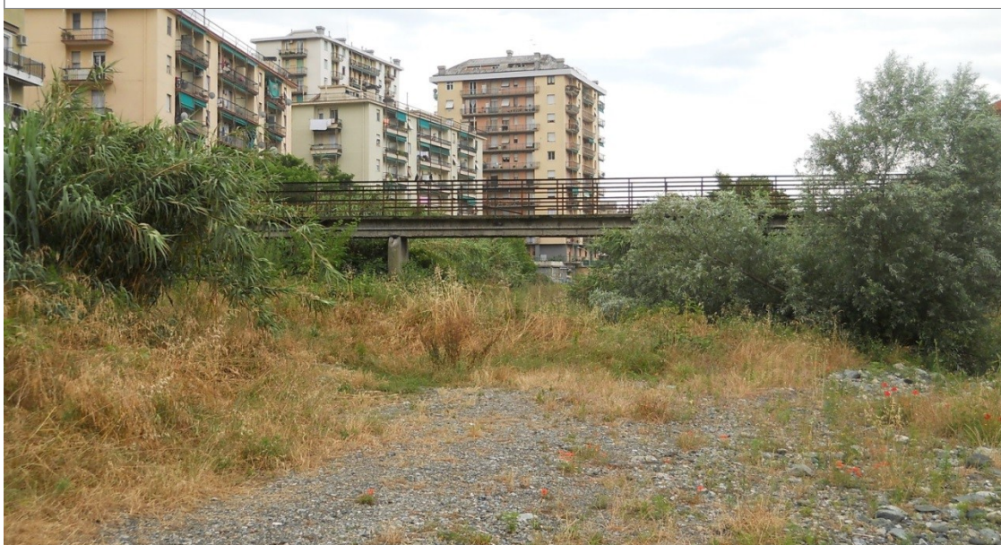
Sezione CHI 37 – vista da monte
