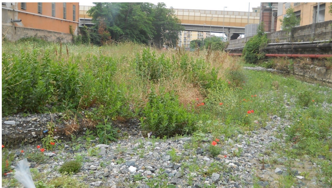
Sezione CHI 30 – vista da monte
