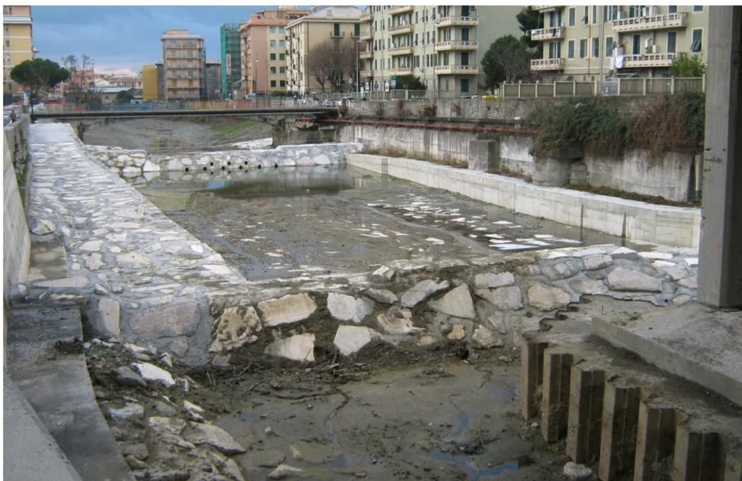
Figura 3.1 Vasca di sedimentazione realizzata immediatamente a valle del viadotto autostradale.
