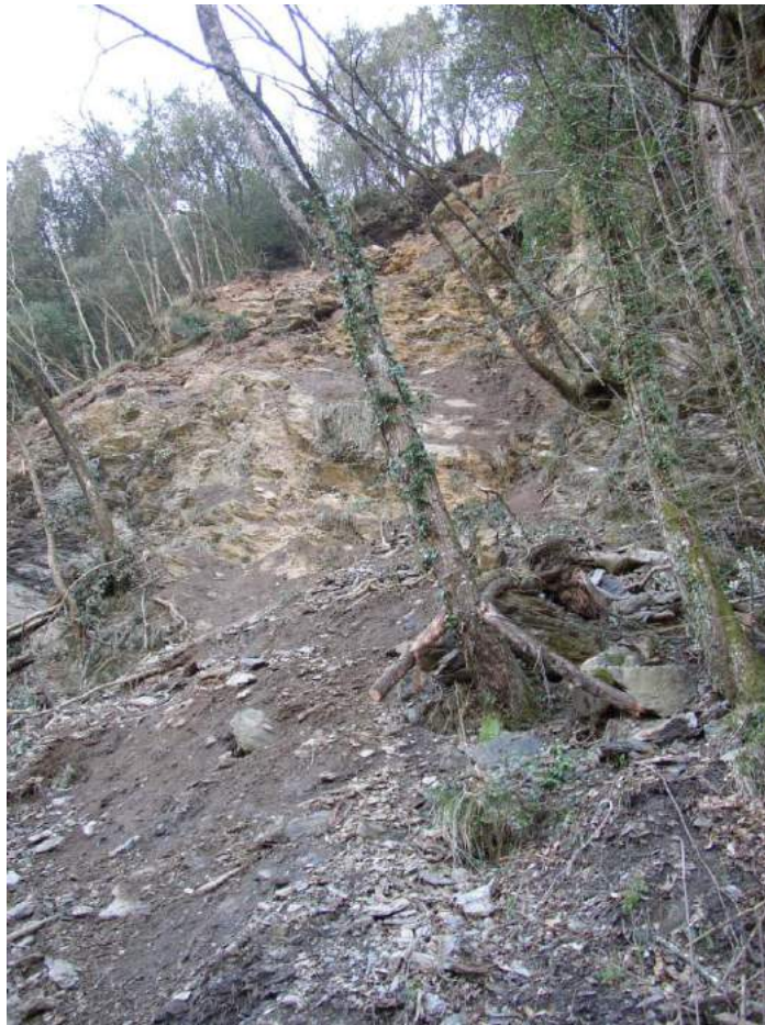
Foto 2 frana di crollo avvenuta nel mese di Gennaio 2005
