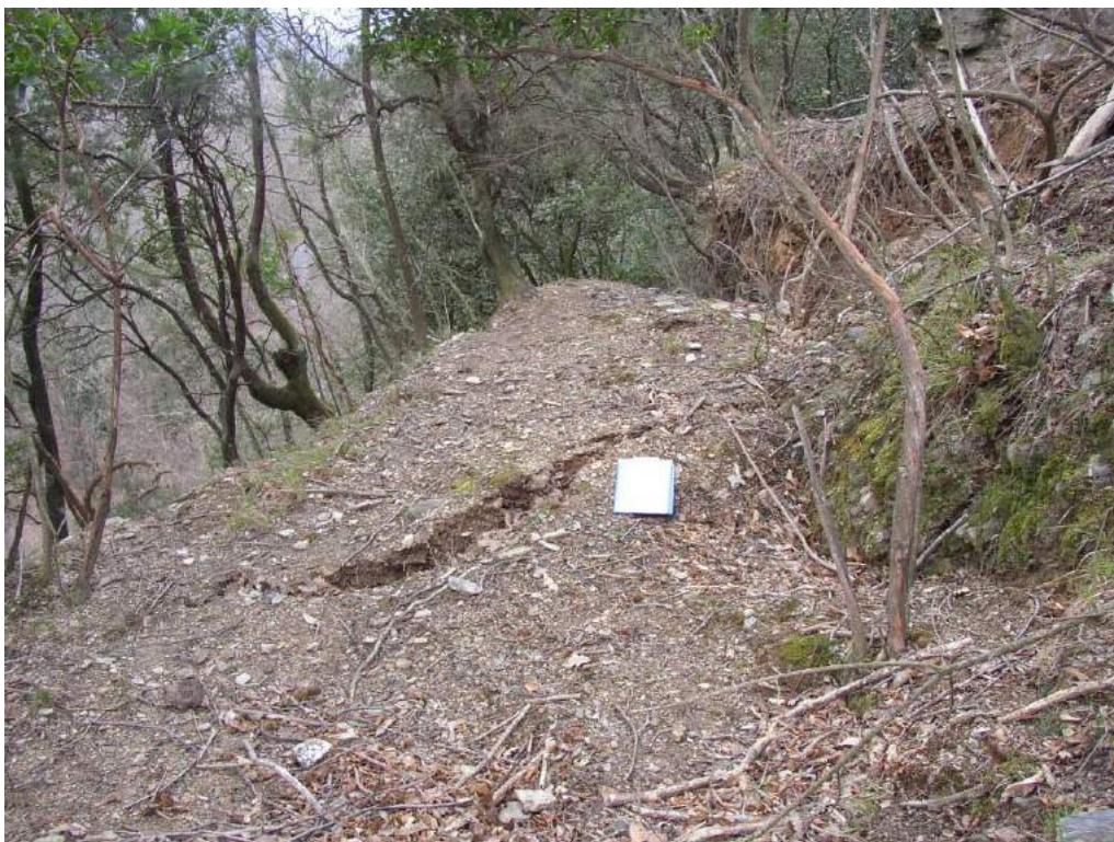
Foto 3 fratture di tensione a monte del ciglio di distacco del movimento franoso attivo.
