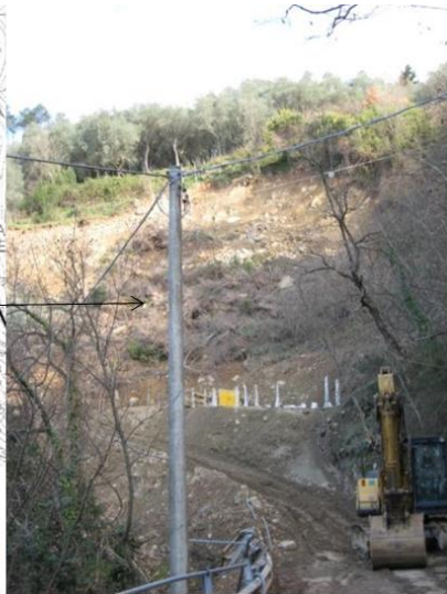
CARUGGIO SAN MARTINO, IN ROCCIA E COLTRE, INTERROTTA LA S.C., IN FASE DI REALIZZAZIONE INTERVENTO DI SISTEMAZIONE (PALI, ECC.). COMUNE DI SAN COLOMBANO CERTENOLI
