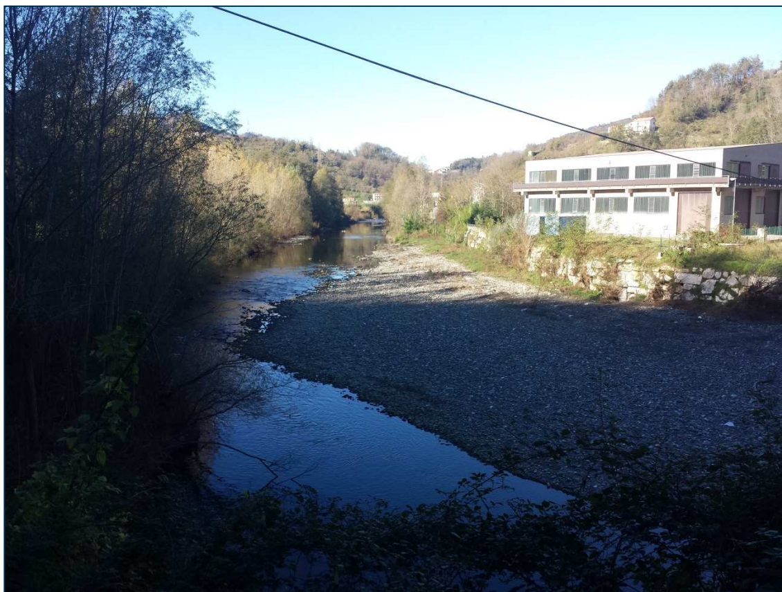
Figura 8.2 Torrente Lavagna in corrispondenza della sezione LAV21, vista verso monte.
