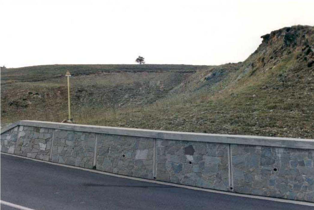
Scavi lungo la strada per i Piani di Praglia
