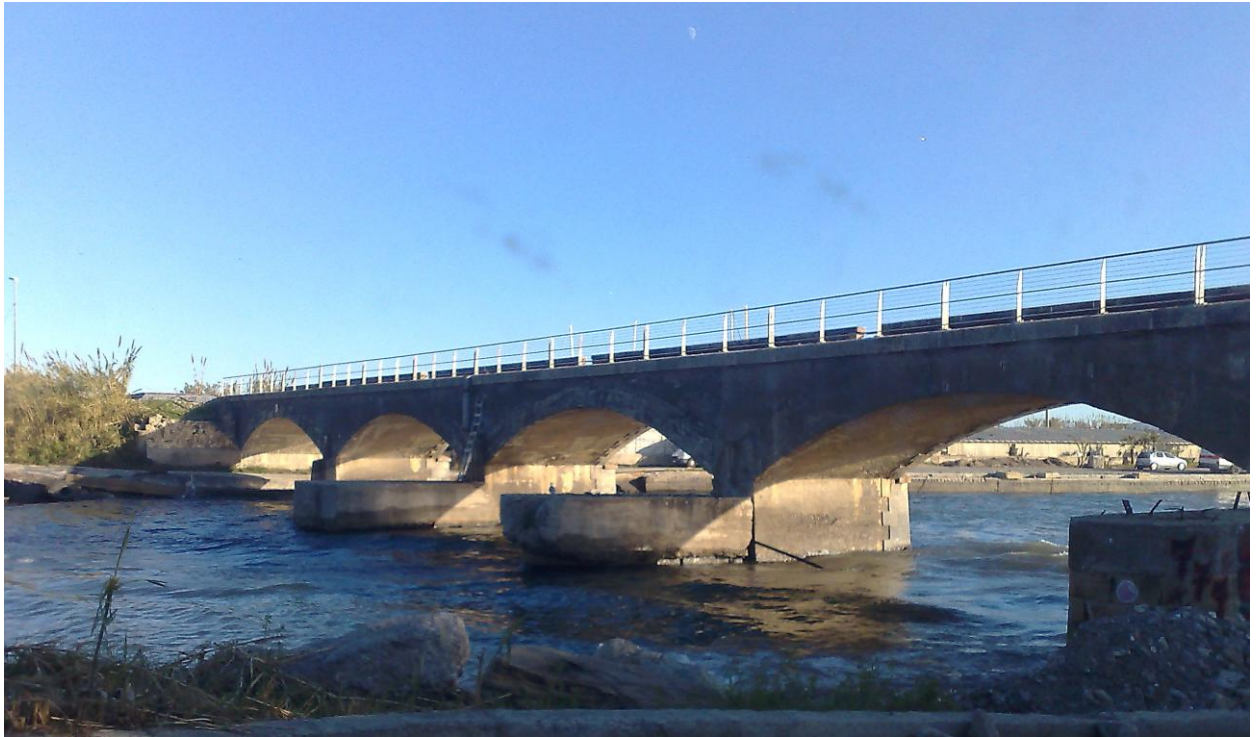
Figura 1-4: ponte di foce (ex ferroviario)
