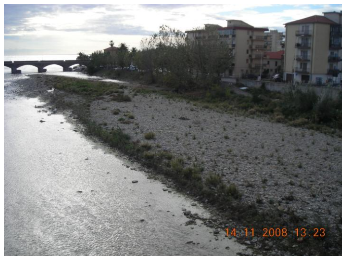
Figura 1-12: Difesa in destra idraulica (vista dal ponte S.S. 1 verso valle)
