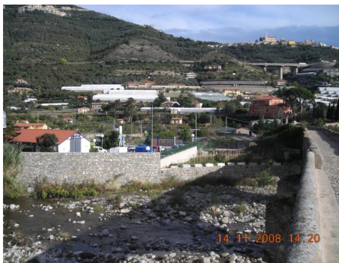
Figura 1-9: Ponte Romanico – varco nella linea di difesa in sinistra idraulica
