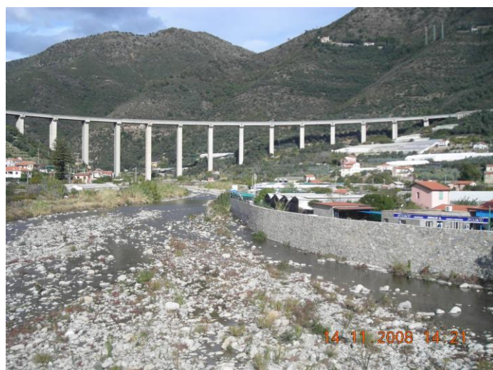
Figura 1-10: Ponte Romanico – muro in c.a. in sinistra idraulica (ripreso dal ponte romanico verso monte)
