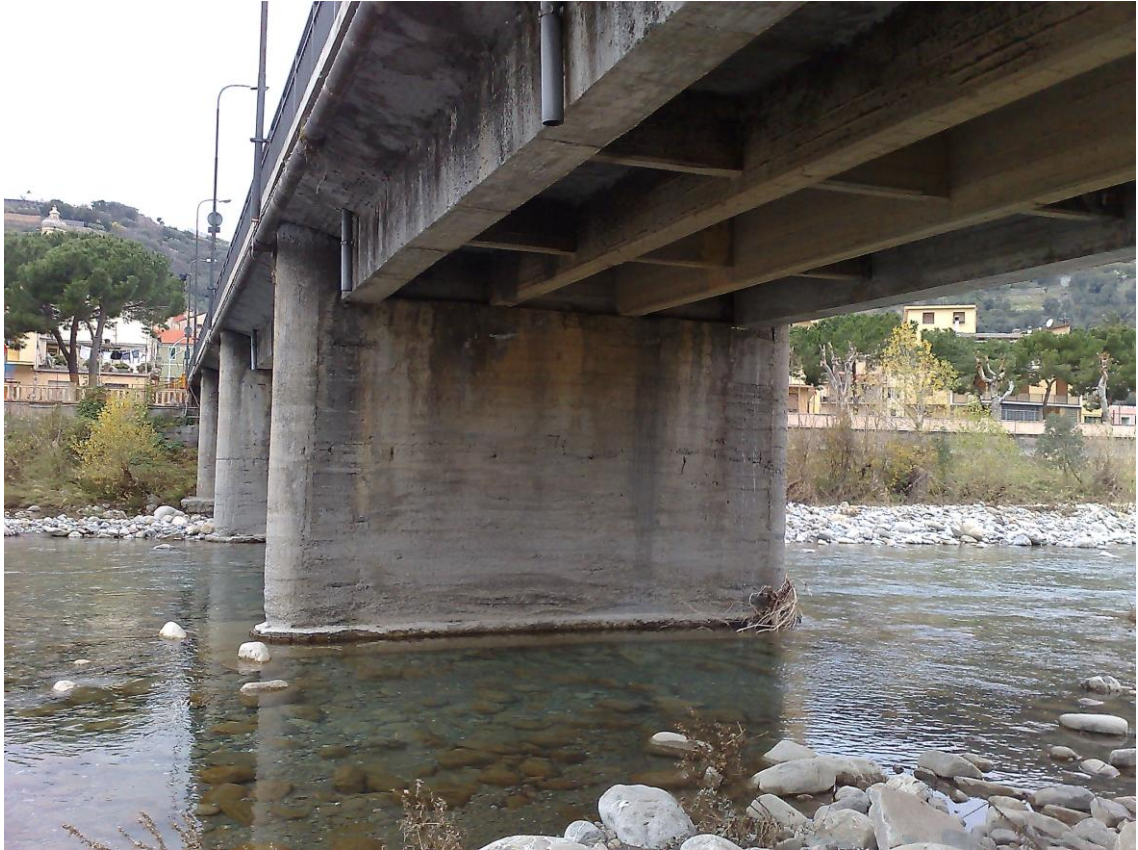
Figura 1-6: ponte di Taggia
