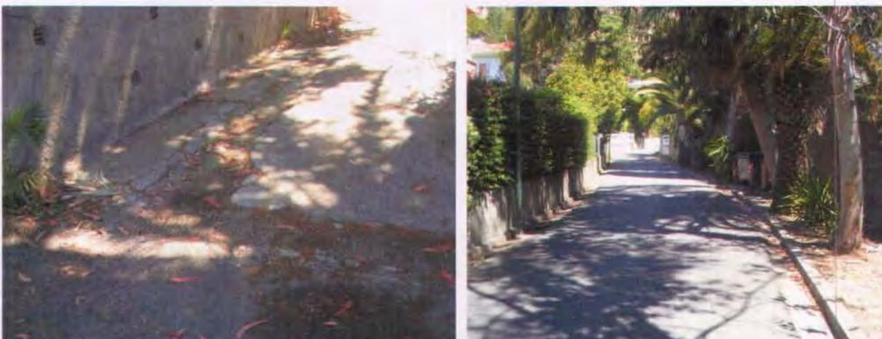
Figura 7 – Sistema di drenaggio di via Conca Verde. Presenza di caditoie intasate (sx), sistema di collettamento con canaline laterali e muri che impediscono apporti esterni diretti.
