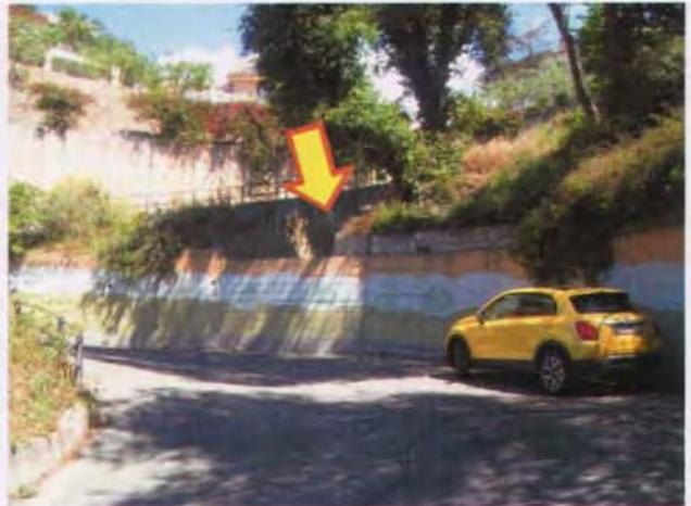
Figura 4 – Strada asfaltata che si sviluppa a tornanti sull'originario alveo del rio; la freccia indica lo sbocco di un tombino circolare del sistema di drenaggio entro un pozzetto di salto.
