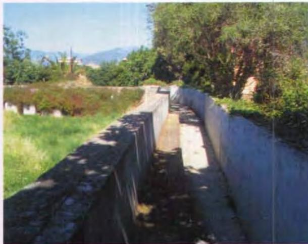
Figura 12 – Tratto delle due curve a 90°, con “bauletto” in calcestruzzo che restringe il fondo della sezione.
