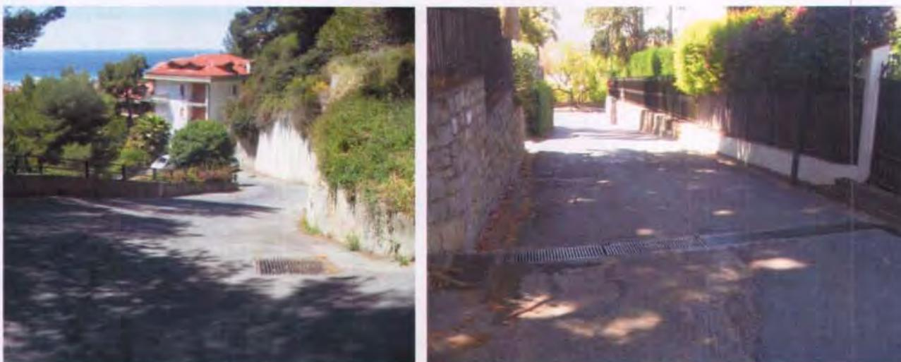
Figura 6 – Sistema di drenaggio di via Conca Verde. Caditoie puntuali o a tutta larghezza.
