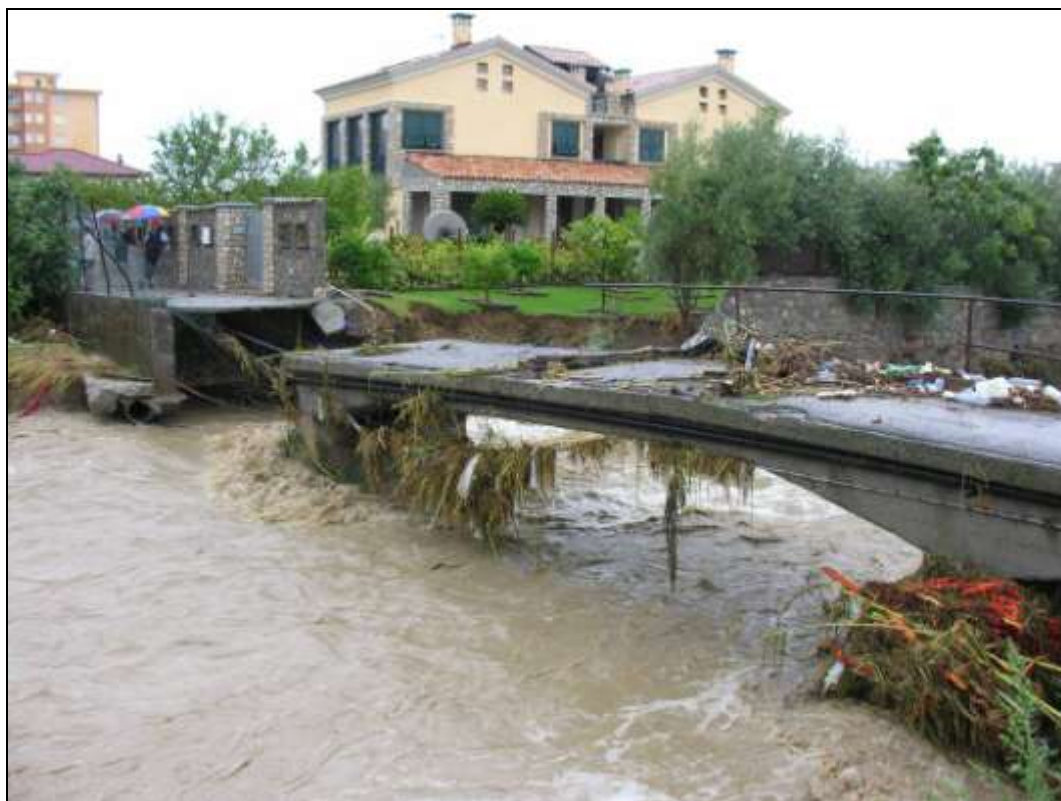
Figura 2.1: Vallecrosia: ponte privato (successivamente abbattuto) situato appena a monte della sede delle Poste.
