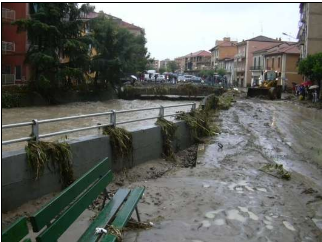
Figura 2.3: Vallecrosia: tratto compreso tra la sede delle Poste e il ponte di via Angeli Custodi.
