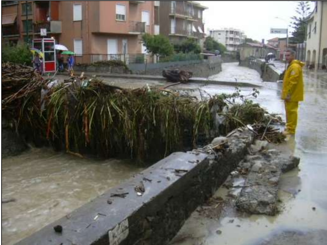
Figura 2.5: Borghetto: ponte di via Aldo Moro.
