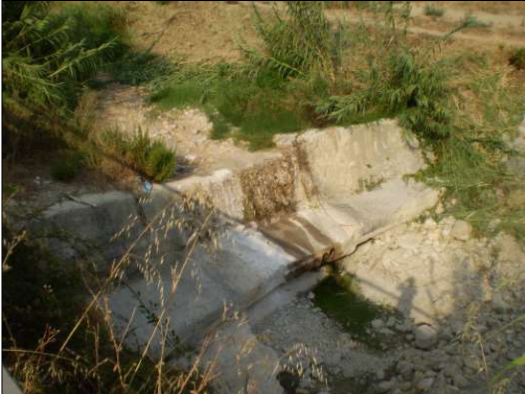
Figura 2.12: Vista ravvicinata del salto di fondo sul torrente Borghetto in prossimità di via Pisciavina
