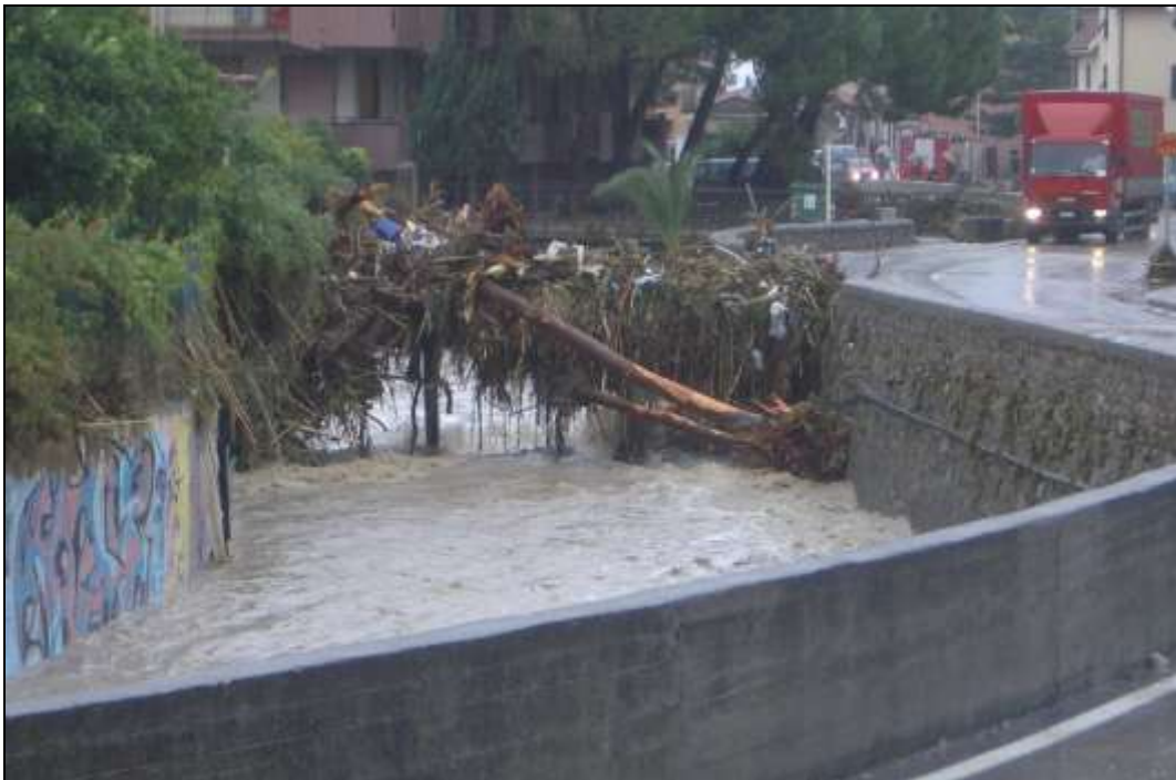
Figura 2.6: Borghetto: tronchi ed arbusti ammassati sul ponticello situato tra la tombinatura a valle di via Romana e il ponte di via Aldo Moro.
