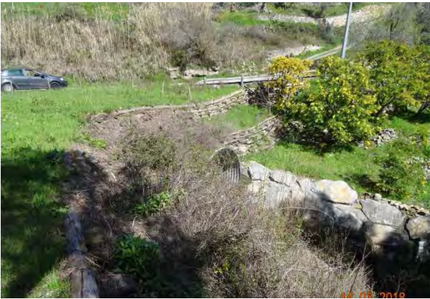
Intervento di sistemazione presso zona PG4
