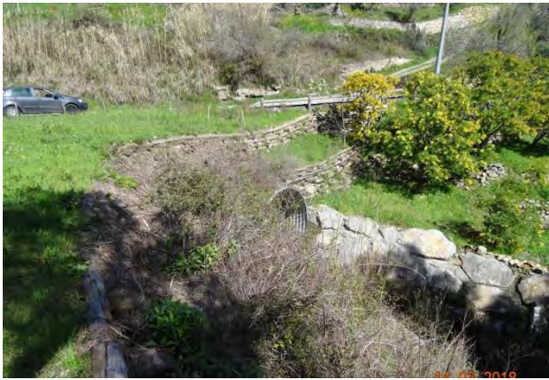
Intervento di sistemazione presso zona PG4
