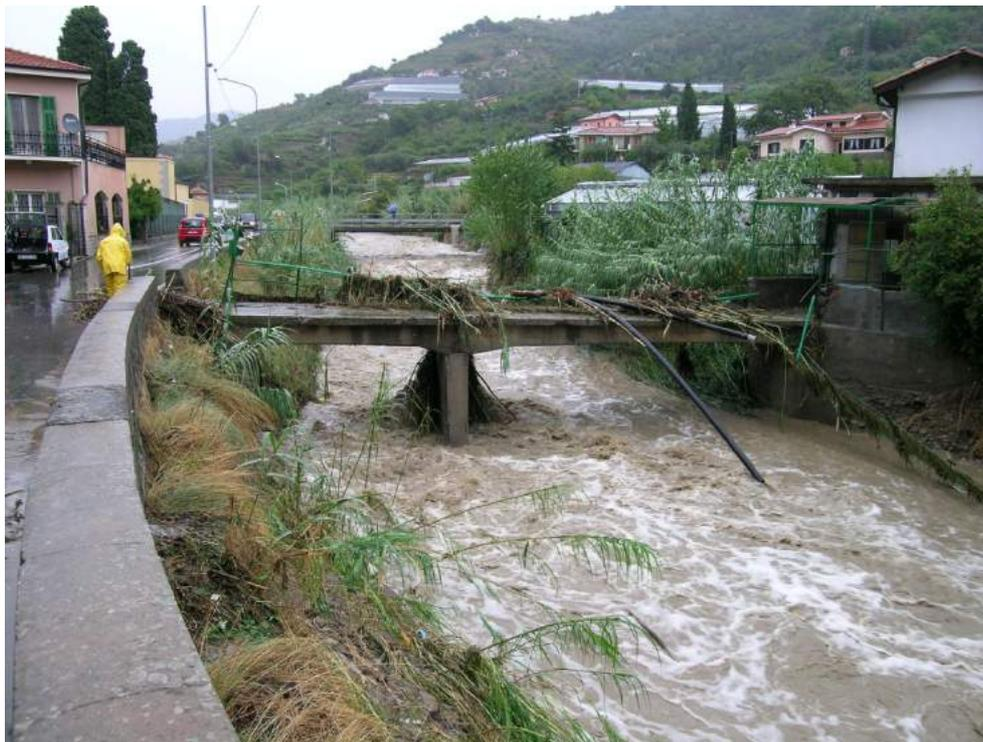
Fig. 24. passerella sez. 32 demolita a seguito alluvione. Sullo sfondo nuovo ponte Sanferian ricostruito post evento 2000
