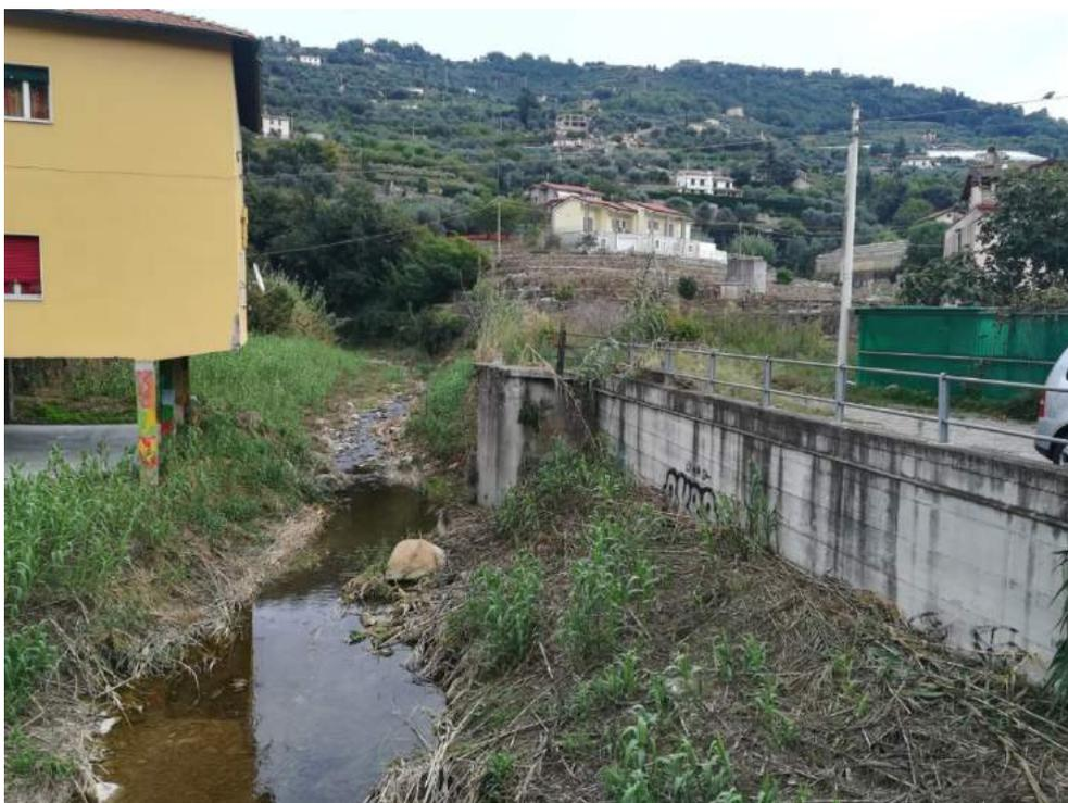
Fig. 14. ripresa dal ponte di via Caduti del Lavoro del tratto ricompreso tra quest'ultimo e la sezione 13: in evidenza il restringimento in sezione 9 determinato dal profilo dell'arginatura sinistra e dall'ingombro dell'edificio su pilotis
