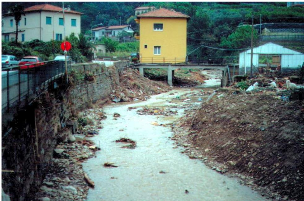
Fig. 16. caseggiato in alveo di cui alla fig. 14 e ponte demolito a seguito dell'alluvione 2006
