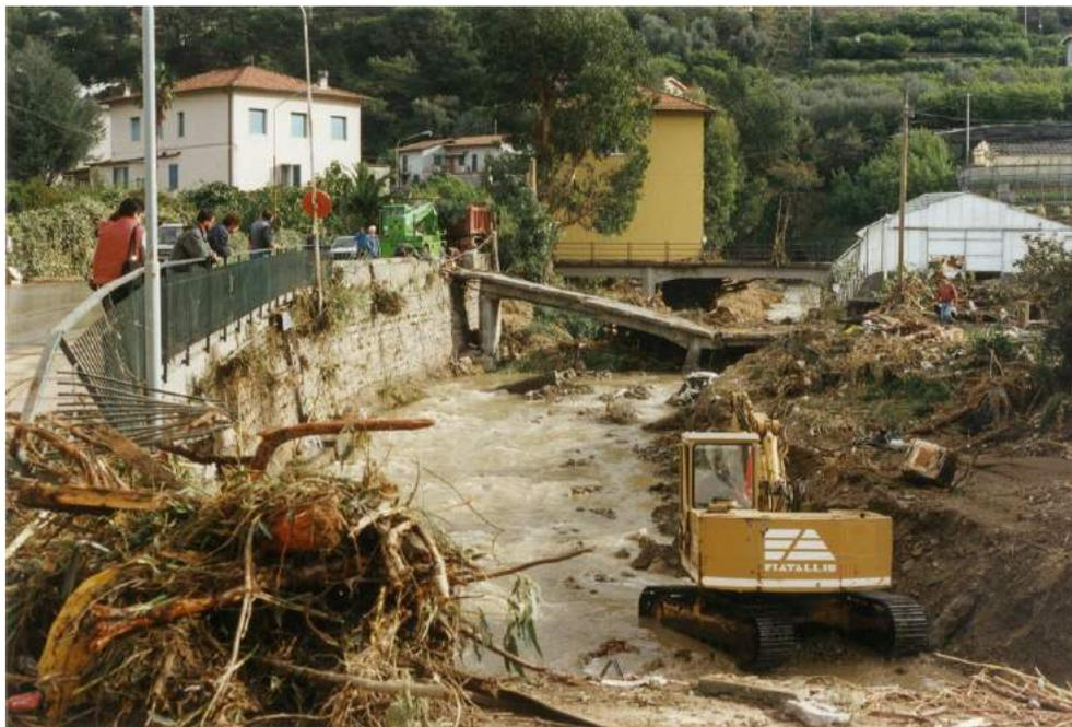
**Fig. 15. ponte via Caduti del Lavoro collassato a seguito della piena**
