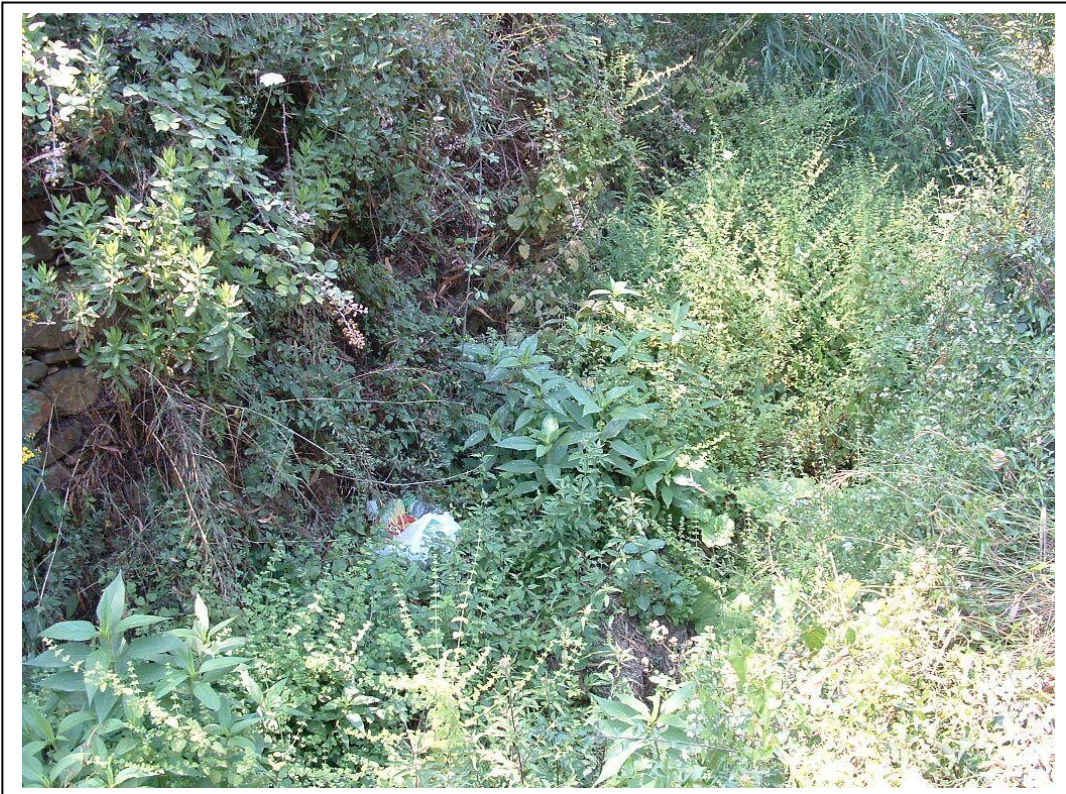
Foto 2 – Alveo del Torrente Gorleri invaso da vegetazione e rifiuti
