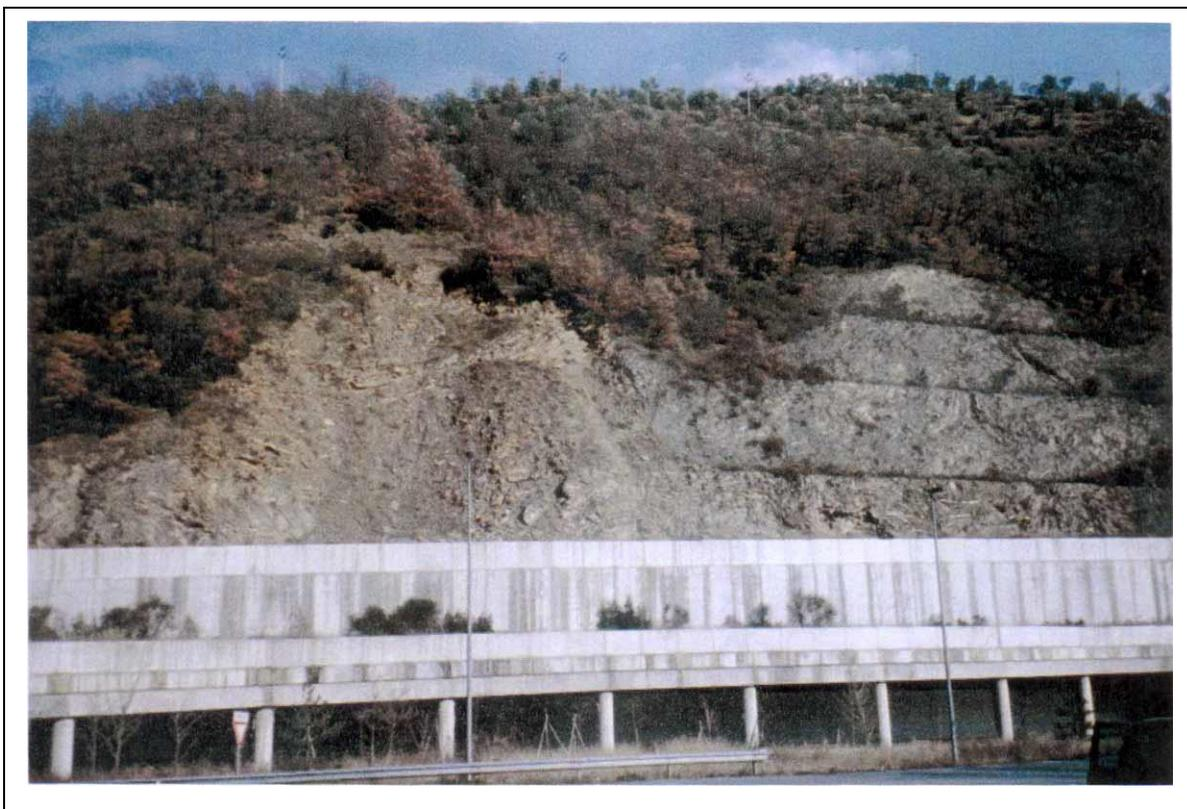
**FOTO 14:** il crollo avvenuto all'imbocco della galleria paramassi di Arzeno d'Oneglia, a causa dell'errato consolidamento del versante e della mancata conduzione delle acque di ruscellamento superficiali.
