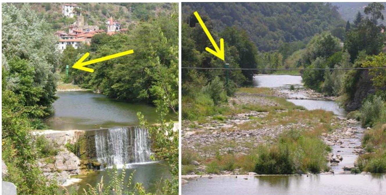
Figura B.1.1. Stazione idrometrica di Isolabona: vista da valle (sx) e da monte (dx) - foto Agosto 2007.
