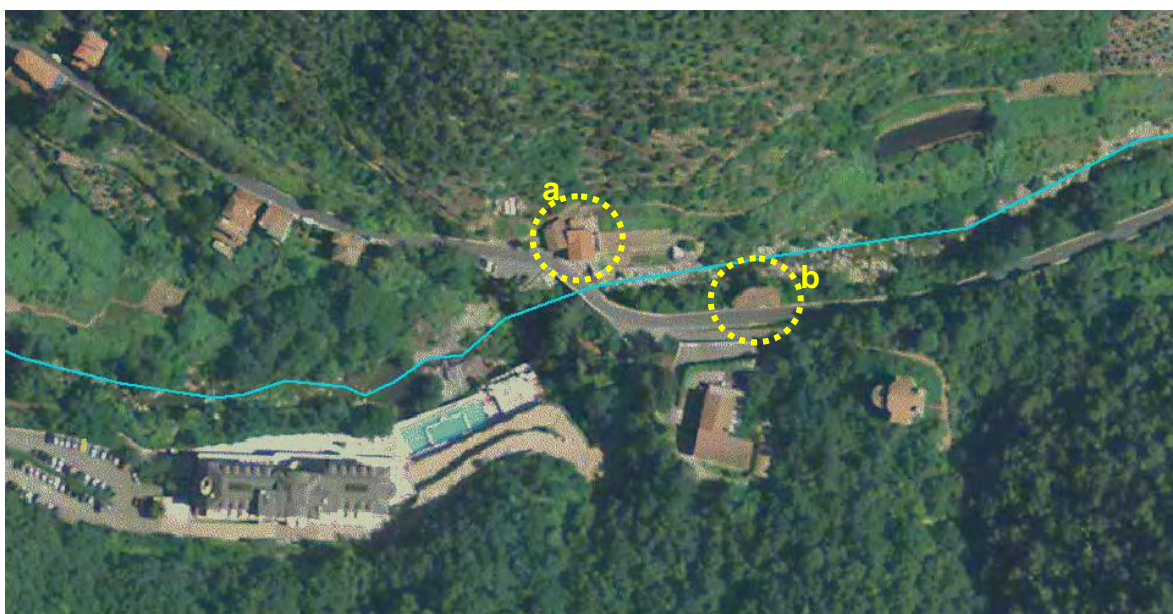
Figura 5.4 - Torrente Nervia a monte di Pigna, sono evidenziati i due edifici a rischio posti in destra idrografica subito a monte del ponte (a) e in sinistra idrografica tra la strada provinciale e il corso d'acqua (b).
