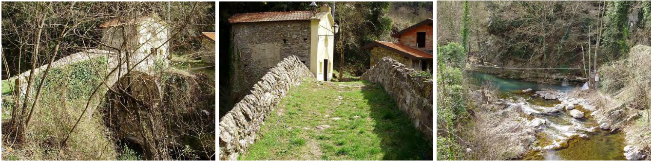
Figura 5.5 - Immagini del ponte a monte della confluenza del Rio di Carne e della confluenza stessa.
