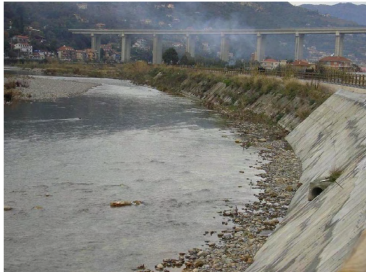
Figura 5.22 - Mantellata in sinistra idrografica tra il ponte sulla S.S. n°1 e il viadotto autostradale
