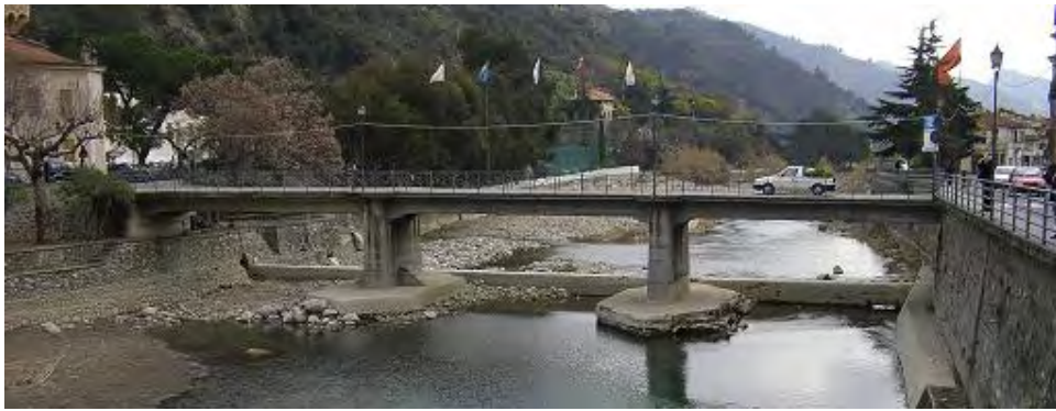
Figura 5.13 -Ponte Novo a Dolceacqua visto dalla sponda destra, è visibile la briglia posta subito a valle dello stesso.
