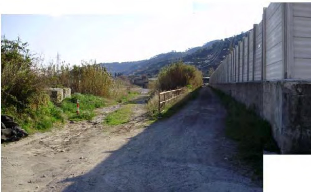
Figura 5.18 - Strada che costeggia la recinzione che delimita la centrale elettrica in destra idrografica.
