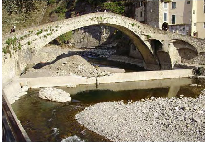
Figura 5.12 - Ponte romano e briglia posta a valle dello stesso, vista da valle..
