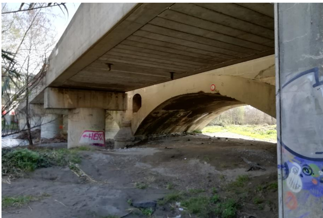
Figura 3.4 Vista da monte verso valle dell'attraversamento ferroviario posto in prossimità del centro di Ventimiglia, in corrispondenza della sezione idraulica ROI-100
