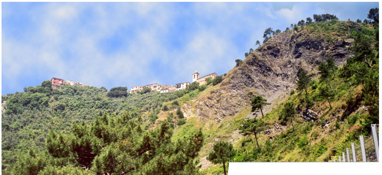
Foto 14 - Il ciglio di arretramento della frana di Guvano che lambisce l'abitato di San Bernardino.
