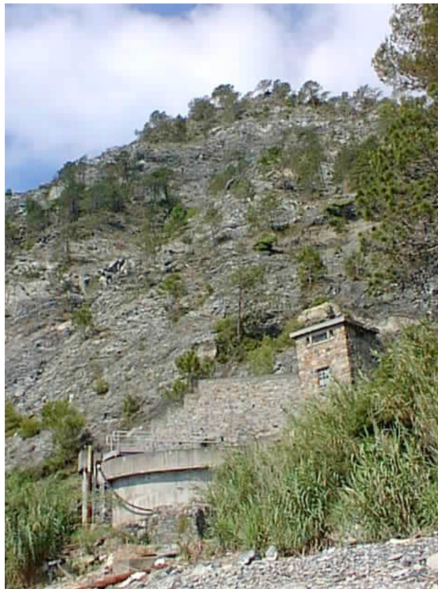
Foto 20- La parete in serpentinite a monte del dismesso depuratore di Monterosso al Mare..
