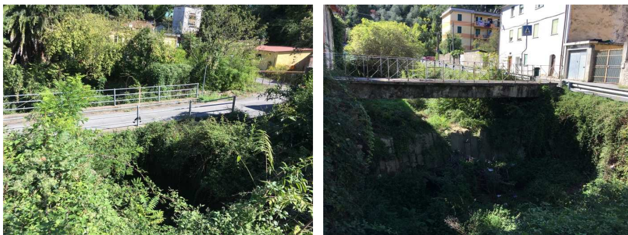
Figura 17 – Ponte di Via Castellana (CP_P1) (sx); vista della passerella CP_P3 di accesso al cimitero da valle con vista su Via Caporacca (dx).
