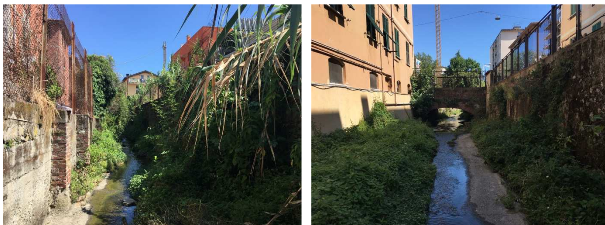
Figura 76 – Alveo a valle di via Cappelletto con sponda sinistra inferiore di quella destra (sx). Attraversamento di via Lunigiana visto da monte (CA_P8, dx).
