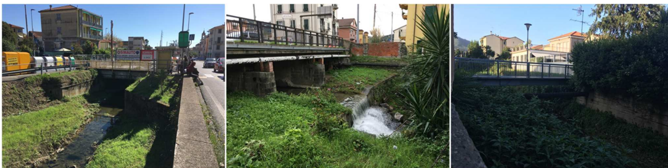
Figura 55 – Imbocco della copertura ND_C1 (sx), ponte ND_P7 sull'Aurelia (centro) e passerella ND_P8 (dx).
