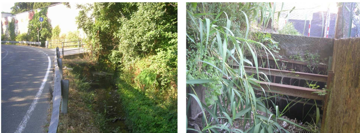
Figura 54 – Vista da valle del ponticello di attraversamento VD_P4 per accesso al cimitero(sx) e l'imbocco della tombinatura VD_C2 (dx).
