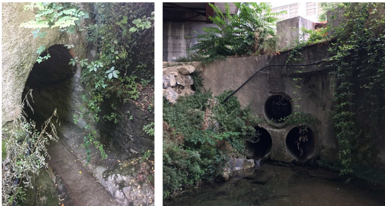
Figura 56 – Imbocco della tombinatura ND_B_P1 sotto edificio (sx) e sbocco della tombinatura ND_B_C3 (dx) del Fosso Buonviaggio.
