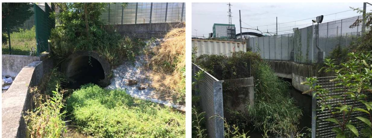
Figura 24 - Imbocco tombinatura ME\_C01 al di sotto del depuratore (sx); vasca di calma a valle dell'attraversamento ferroviario vista da valle (dx).
