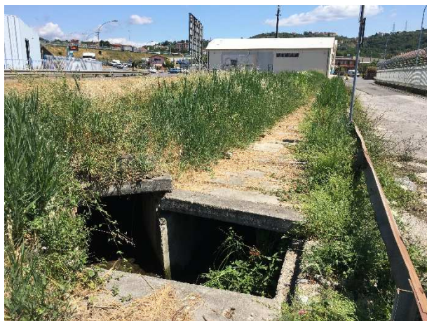
Figura 25 – Nodo scoperto di confluenza dei due rami di monte del rio Colombiera, visto da valle (sx); area dove si verificano le prime ingressioni di portata entro il sito della centrale ENEL (dx, attraverso la recinzione a destra nella foto che fiancheggia la stradina che viene allagata dal rio Colombiera).
