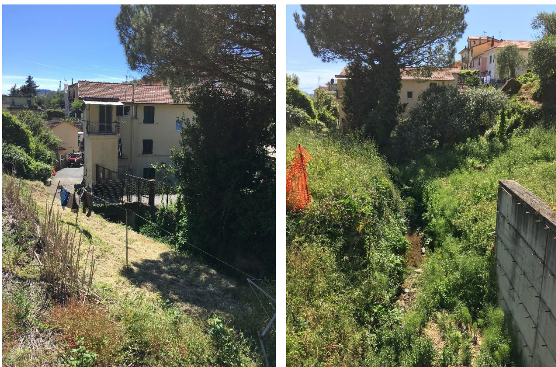
Figura 29 – Tratto di fosso Pezzogrande a monte della tombinatura (PZ_C1), dove si verificano le esondazioni che vanno a interessare le aree a valle.
