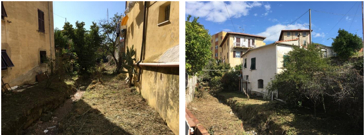
Figura 32 – Fabbricati a uso residenziale con affacci diretti sull'alveo, allagabili in condizioni di piena.
