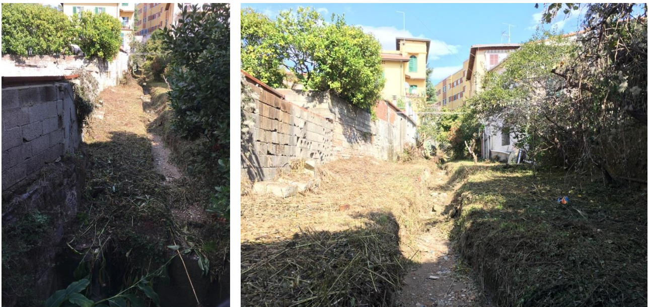
Figura 33 – Muro di sponda destra in blocchetti di calcestruzzo prefabbricati.
