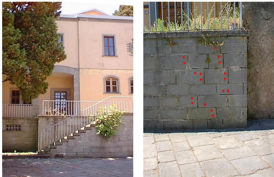
**Figura 36 - L'ex convento. Evidenti scollature in corrispondenza dei pesanti conci in arenaria riquadrata di un muro di sostegno del ballatoio.**
