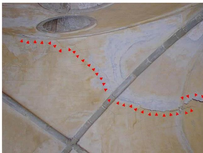
**Figura 34 - Lesione in corrispondenza della volta del porticato.**
