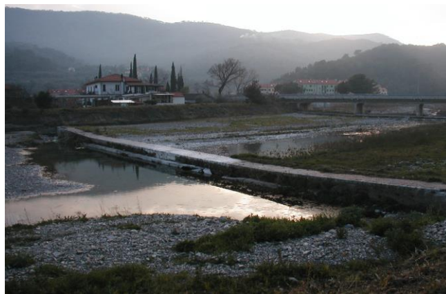
Foto 2.6.1.13 Torrente Merula - briglia sez. 68 e ponte Strada Provinciale N. 13 sez. 72 (foto marzo 2006).
