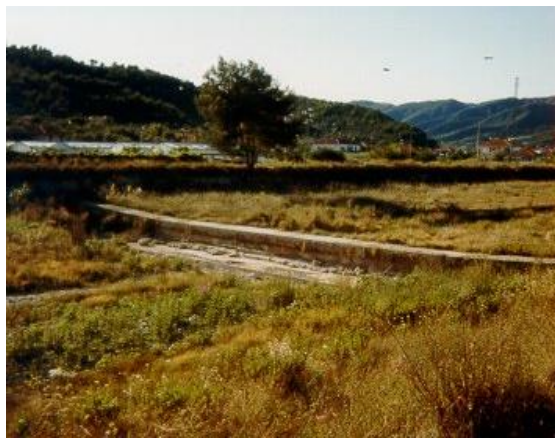
Foto 2.6.1.10 Torrente Merula - foto di una delle tante briglie posizionate nell'alveo del torrente
