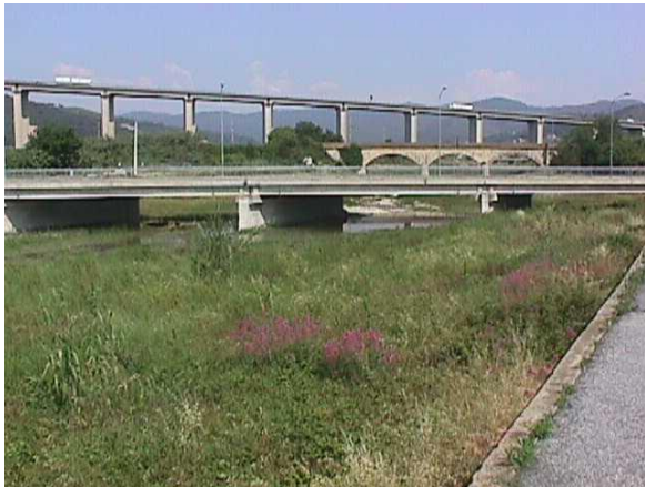
Foto 2.6.1.4: Torrente Merula - ponte Europa Unita – si noti come la struttura in esame riduca notevolmente la luce libera di deflusso. Sullo sfondo, il ponte della ferrovia ed il viadotto autostradale
