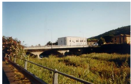
Foto 2.6.1.1: Torrente Merula – Vista della foce a sinistra e foto del ponte dell'Aurelia a destra. Si noti la presenza di un campeggio in sponda sinistra, prospiciente al Torrente lungo un tratto privo di alcuna protezione.
