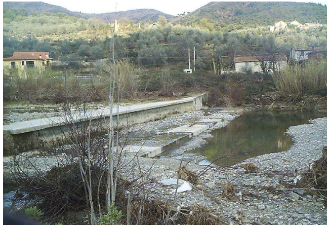
Foto 2.6.1.12 Torrente Merula - Esempio di briglia e controbriglia nel tratto tra loc. Molino Nuovo e loc. Castellana (sez. 92) (foto marzo 2006).
