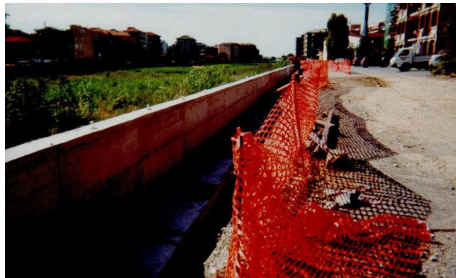
Foto 2.6.1.3: Torrente Merula – particolare dei lavori arginali in sponda destra
