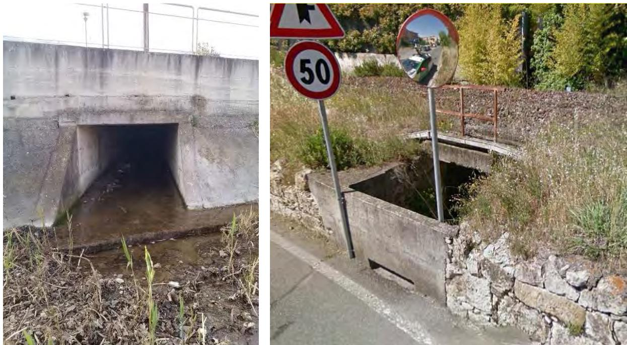
**Figura 22 – Sezione di sbocco del Rio 2 nel torrente Merula (sx) e imbocco tombinatura a valle dell'attraversamento del rilevato ferroviario (dx).**
