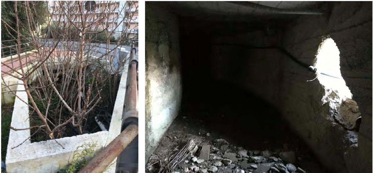
Figura 21 – Vasca di raccordo a cielo aperto all'incrocio con via Carminati (sx). Interno della tombinatura in corrispondenza dell'apertura laterale nel tratto di valle (dx).
