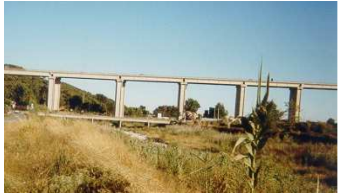
Foto 2.6.1.5: Torrente Merula – Ponte di Strada S. Caterina visto da monte. Si intravede dietro il viadotto dell'autostrada
