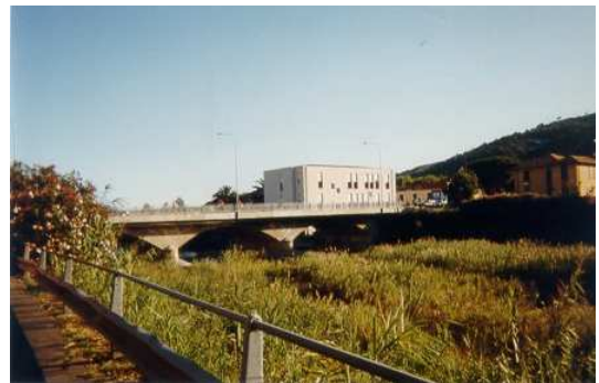
Foto 2.6.1.1: Torrente Merula – Vista della foce a sinistra e foto del ponte dell'Aurelia a destra. Si noti la presenza di un campeggio in sponda sinistra, prospiciente al Torrente lungo un tratto privo di alcuna protezione.
