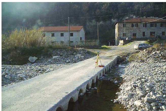
Foto 2.6.1.11 Torrente Merula - Guado in corrispondenza della sezione 95 (foto marzo 2006).
