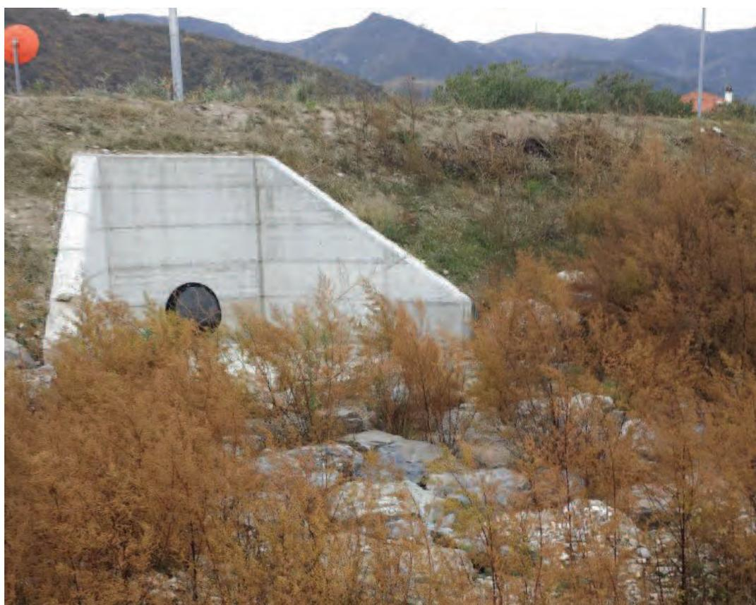
Figura 2.6 Esempio di scarichi protetti da clapet (foto 2 in planimetria).
