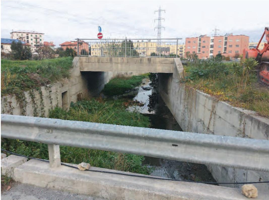
Figura 2.10 Nuova sezione del rio Avarena (vista verso valle) a seguito dei lavori di adeguamento idraulico (foto 66 in planimetria).
