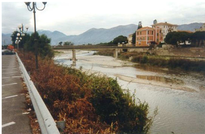
Fig. 2.6.1.3: Fiume Centa - Passerella pedonale vista da valle
