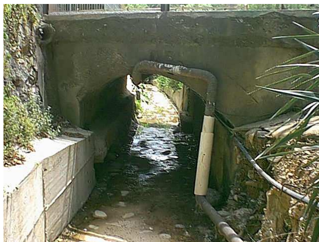
Figura 3.5.3.2.3 – Ponticello sella S.S. Valle Arroscia di attraversamento del Rio Olmi
