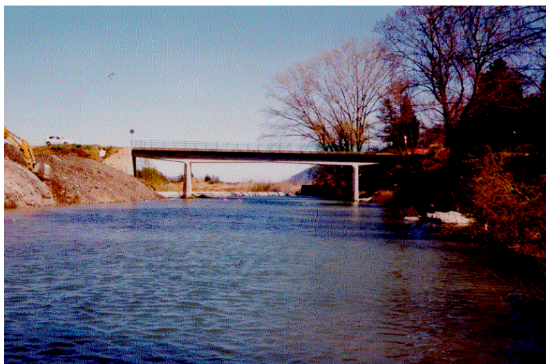
Figura 2.6.1.7: Torrente Arroscia – Comune di Ortovero: ponte stradale per Villanova
