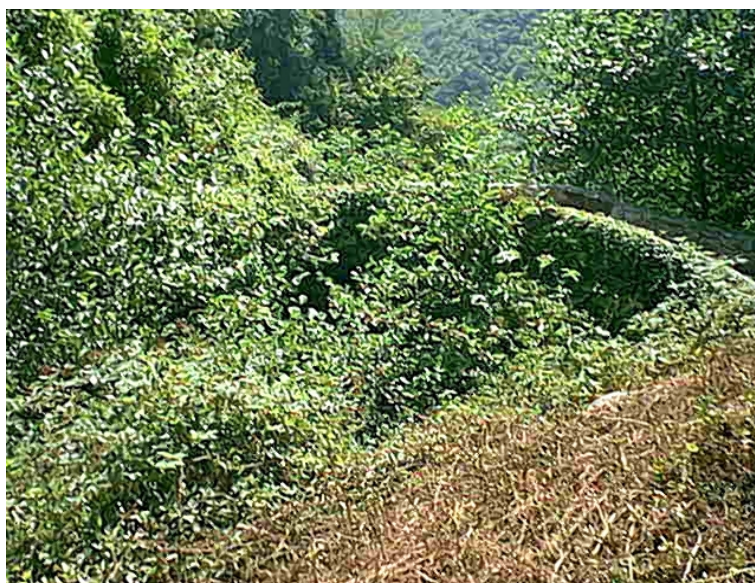
Figura 3.5.3.1.2 – Ponticello che attraversa il rio. Non ci sono pile e l'impalcato è a quota più alta della sponda
