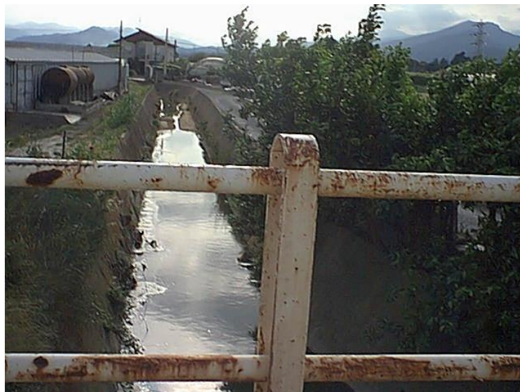
Figura 3.4.1.2.2 – Rio Antognano, vista verso valle.
