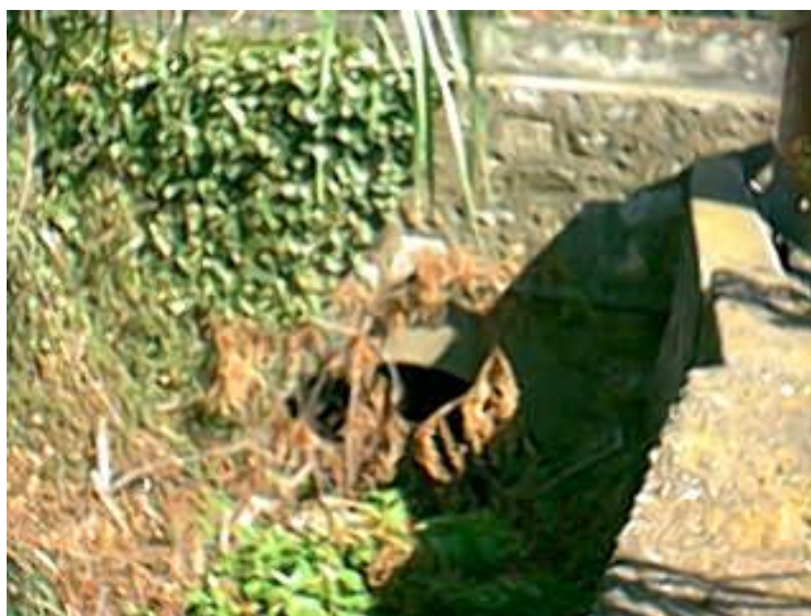
Figura 3.4.1.8.2 – imbocco della copertura del rio Carino.
