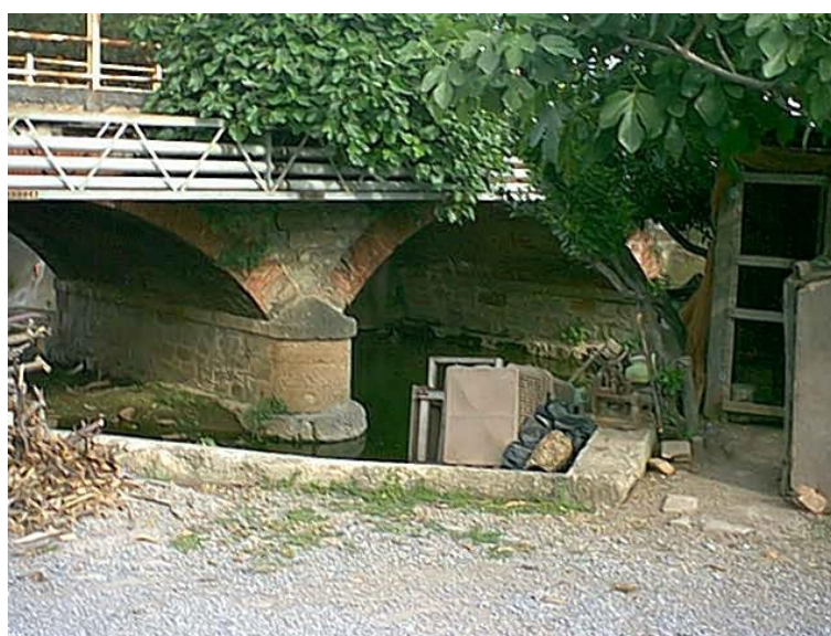
Figura 3.4.1.2.3 – Rio Antognano, ponte della Strada Provinciale
