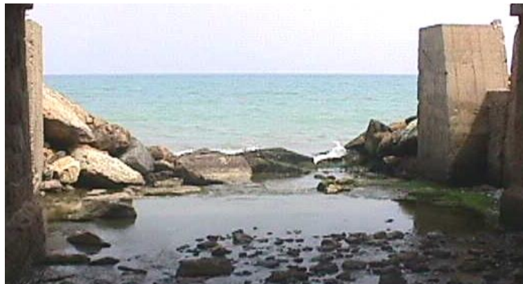
Foto 2.6.1.4 – Torrente Carenda: particolare dello sbocco a mare, a sinistra della pila centrale del ponte della ferrovia.
