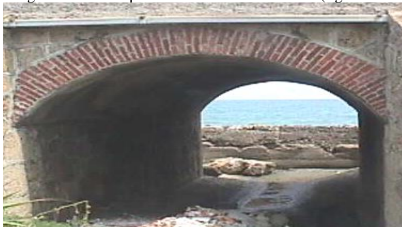
Figura 2.6.3.12 – Secondo rio dopo Antognano: sbocco a mare. Sullo sfondo si può vedere il muro paraonde.
