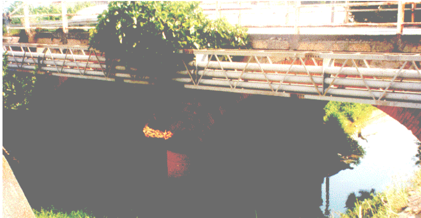
Figura 2.6.3.7 – Rio Antognano: ponte della statale per Campochiesa.
