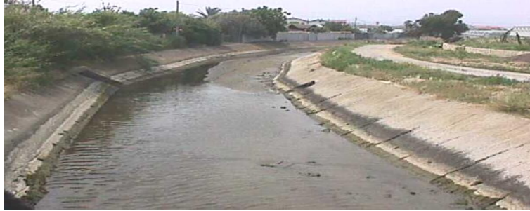
Figura 2.6.3.3 – Rio Antognano: veduta dal ponte della vecchia Aurelia verso monte. Dimensioni sezione trapezia: altezza sponde 2.5 m, larghezza alla base 8 m, larghezza in sommità di 11 m. Pendenza sponde: 30° rispetto verticale.
