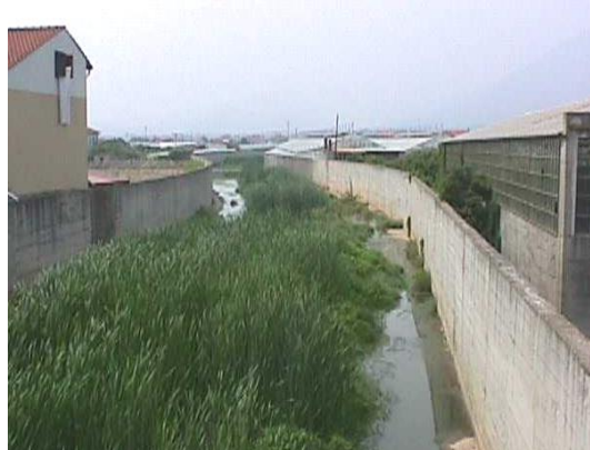
Foto 2.6.1.1 – Torrente Carenda: tratto terminale antistante il ponte della strada
