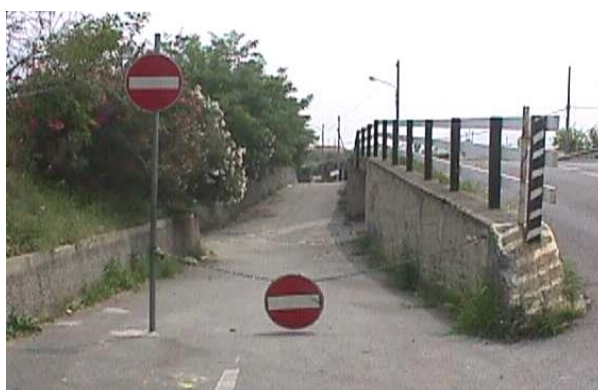
Foto 2.6.2.2 Torrente Torsero: strada di accesso all'alveo (lato di levante)
