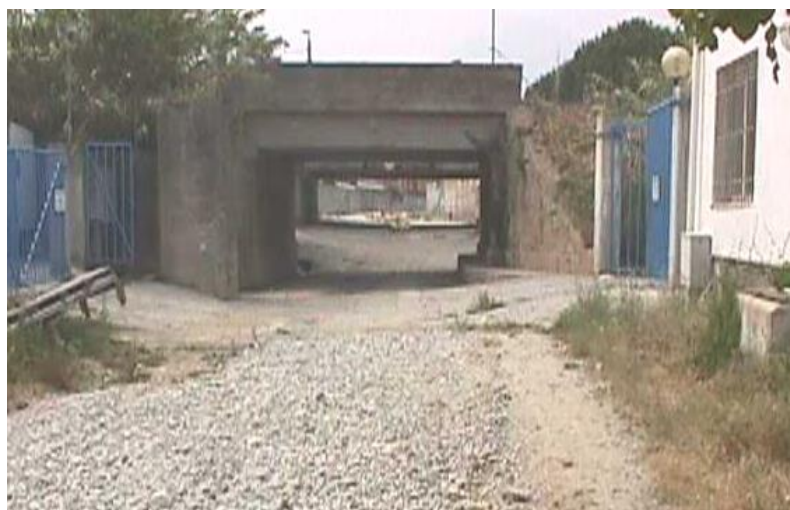
Foto 2.6.2.3 – Torrente Torsero: configurazione dello sbocco dopo il ponte della ferrovia
