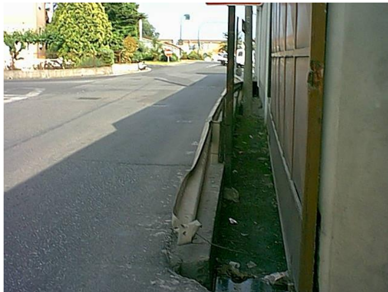
Figura 3.4.1.1.2 – Canaletta di drenaggio contigua alla strada "storicamente inondata"
