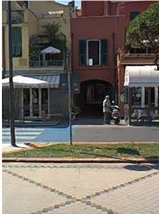
Figura 3.4.1.7.3 – Sottopasso di Via Vietta sotto cui scorre il Rio Recozzolo
