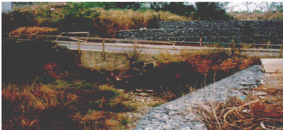
Foto 2.6.1.6: sistemazione di monte con gabbionature del Torrente Carenda. In primo piano il guado allagabile.
