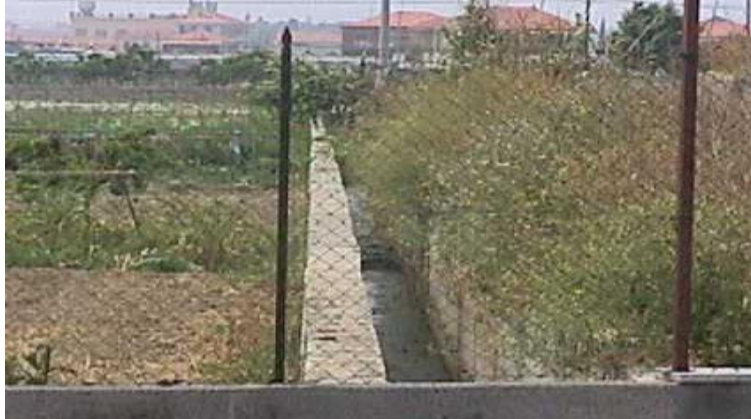
Figura 2.6.3.13 – Terzo rio dopo Antognano: tratto a monte della vecchia Aurelia.
