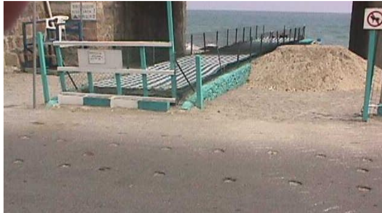
Figura 2.6.3.1 – Rio presso Camping Lionetta: tratto terminale. La sezione del corso d'acqua è di forma rettangolare, rivestita in calcestruzzo.
