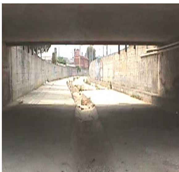
Foto 2.6.2.1 – Torrente Torsero: veduta del tratto terminale prima del ponte della vecchia Aurelia
