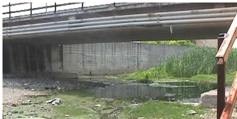
Foto 2.6.1.2 – Torrente Carenda: ponte sulla vecchia Aurelia.
