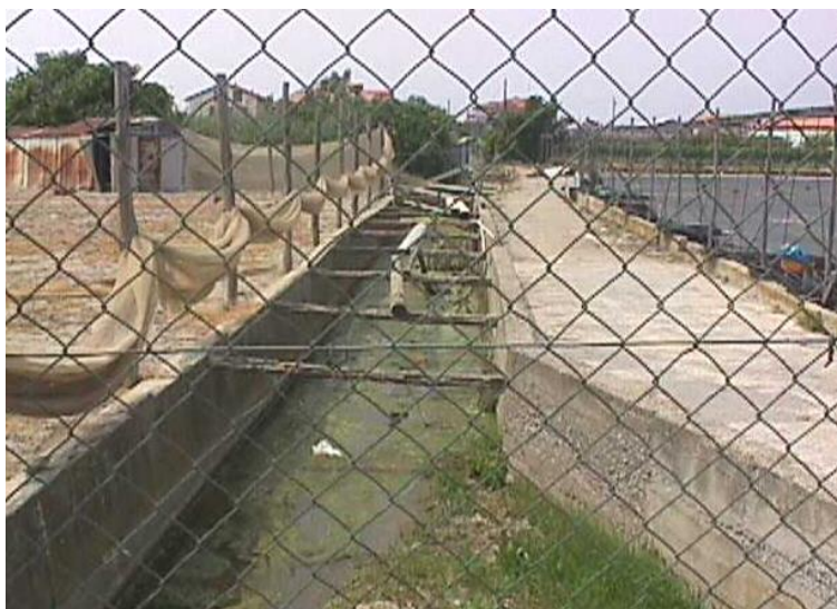
Figura 2.6.3.8 – Primo rio dopo Antognano: visione del tratto a monte della vecchia Aurelia
