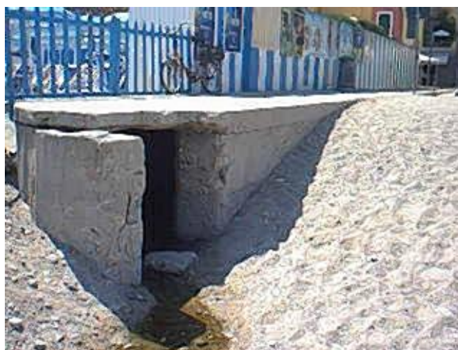
Figura 3.4.1.7.2 – sbocco dello scatolare sulla spiaggia libera
