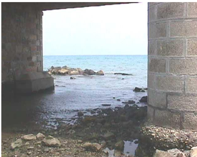
Fig. 2.6.3.6 – Rio Antognano: sbocco a mare tra le pile del ponte della ferrovia.
