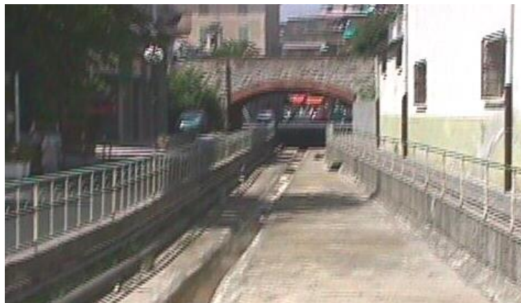
Figura 2.6.4.1 – Rio S. Rocco: tratto a valle dell'Aurelia.
