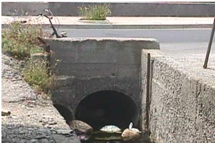
Figura 2.6.3.14 – Terzo rio dopo Antognano: sbocco sotto la strada statale.
