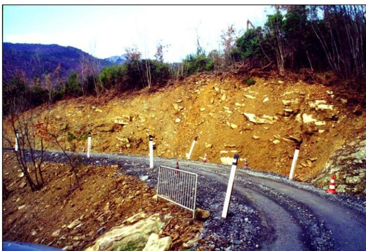
Foto 2.3.6.2 – Loc. Campuriundo: scarpata collassata
