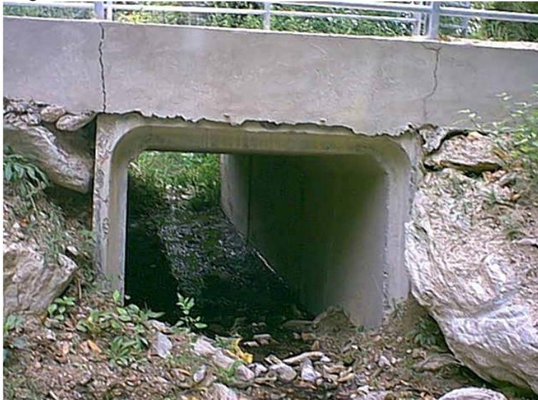
*Figura 3.4.1.1.2 – Scatolare di attraversamento della strada sterrata, installato recentemente.*
