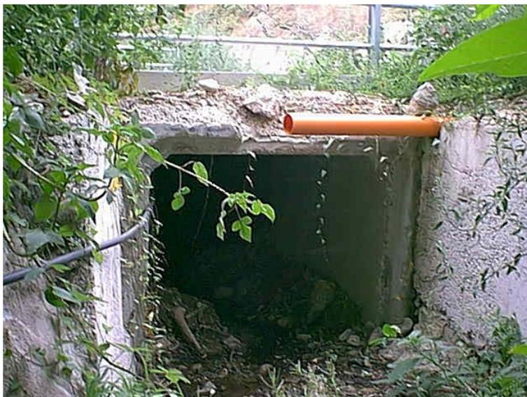
Figura 3.4.1.1.4 - Scatolare di attraversamento della strada asfaltata a valle.
