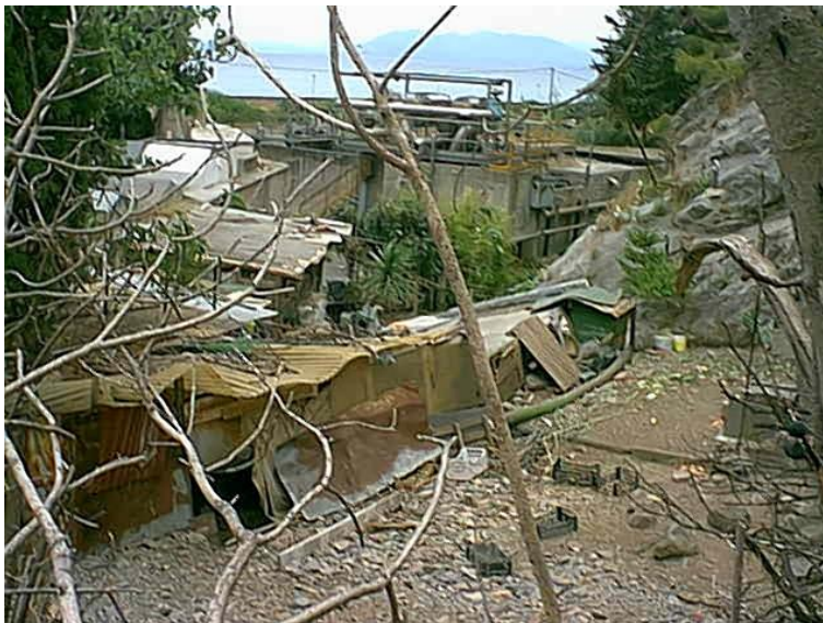
Figura 3.4.1.1.5 – Il compluvio termina contro il muro di cinta dell'ala ovest del cimitero dopo aver incontrato i ricoveri per le capre. Un tubo di drenaggio raccoglie le acque provenienti da monte.
