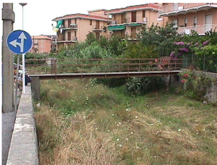
Foto 2.6.1.4: Torrente Bottassano – Passerella pedonale privata – vista da monte
