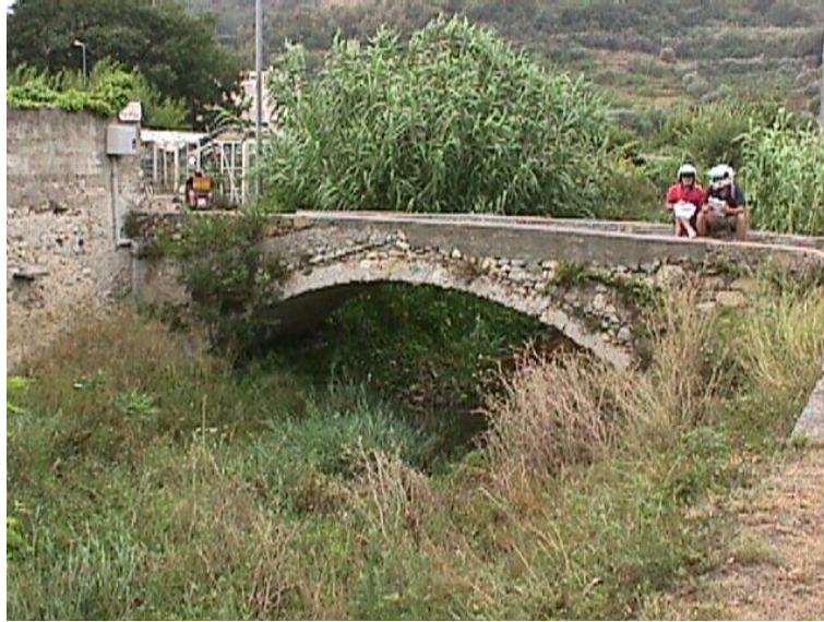
Foto 2.6.1.1: Torrente Bottassano – Ponte di Via Pian Dei Rossi
