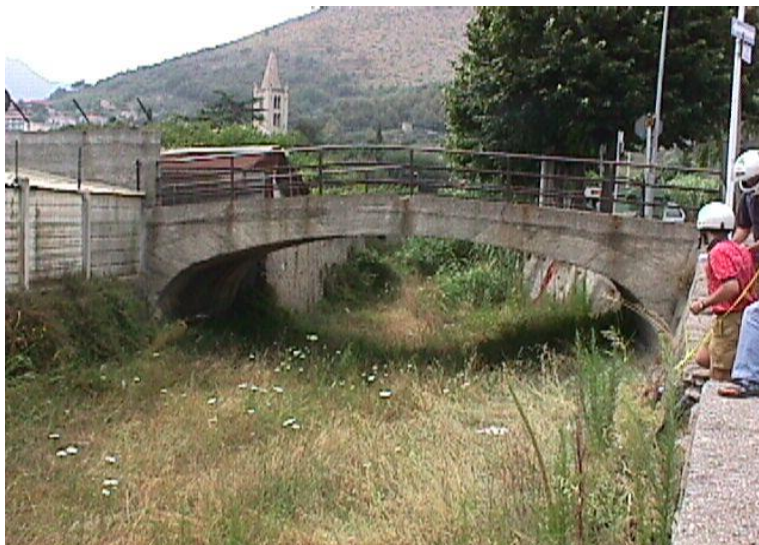
Foto 2.6.1.3: Torrente Bottassano – Ponte all'incrocio di Via Bottassano – vista da valle
