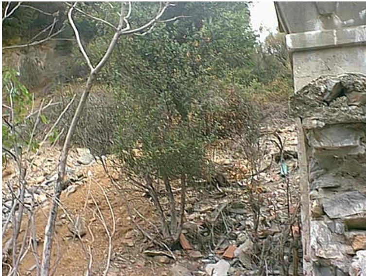
Figura 3.4.1.1.4 – Compluvio nel tratto di monte, fotografia scattata dal muro di cinta dell'ala nord del cimitero.
