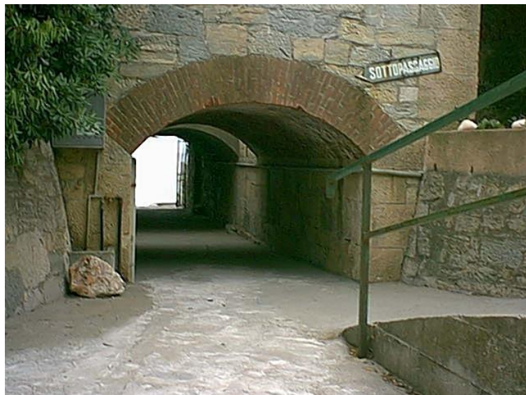
Figura 3.4.1.1.8- Sottopasso pedonale. Le acque del Rio provenienti dal tubo di raccolta defluiscono al di sotto dello stesso fino al mare.
