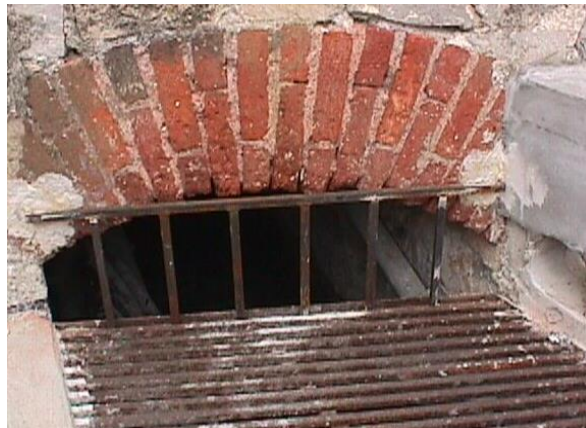
Figura 2.6.2.1 – Rio Fine: sezione di imbocco all'attraversamento della SS Aurelia.
