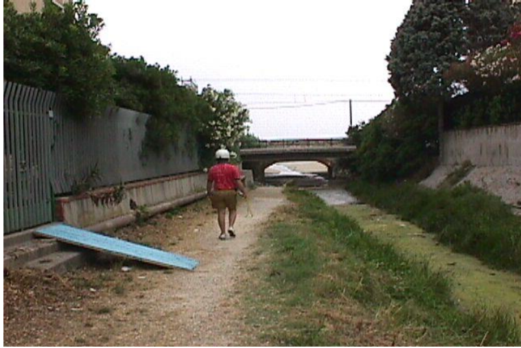
Foto 2.6.1.7: Torrente Bottassano – particolare degli argini in sponda destra e sinistra; si noti la differenza di livello degli stessi.
