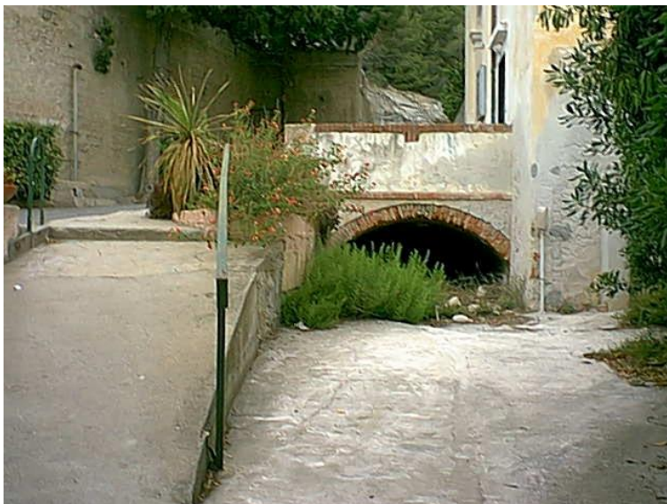
Figura 3.4.1.1.6 – Sbocco della copertura di accesso al cimitero. Le acque defluiscono sulla strada del sottopasso fino al mare.
