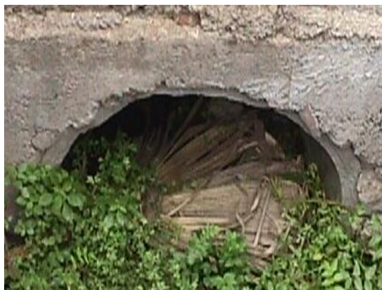
Figura 2.6.2.4 – Rio Fine: particolare della tubazione di imbocco.
