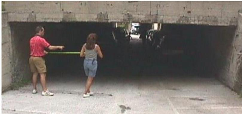
Figura 2.6.2.2.2 – Rio Porio: ingresso della copertura sotto il residence. Dimensioni: 1.8 m x 6.10 m.
