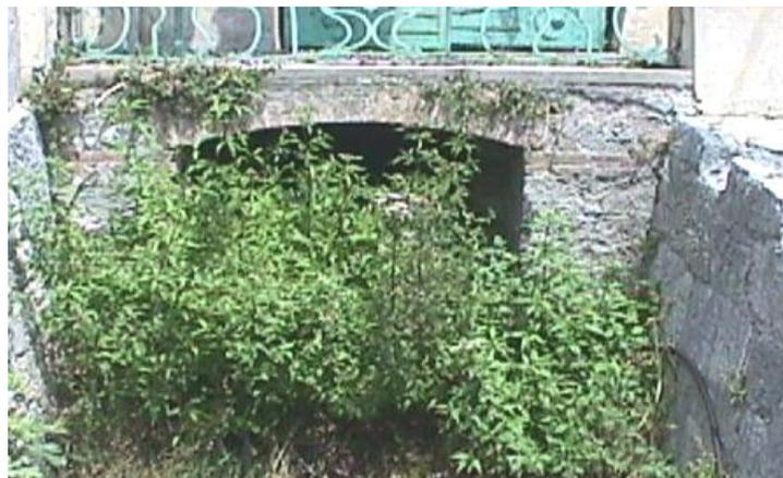
Figura 2.6.2.3.1 – Rio Goello: sezione di sbocco del tratto coperto di monte.
