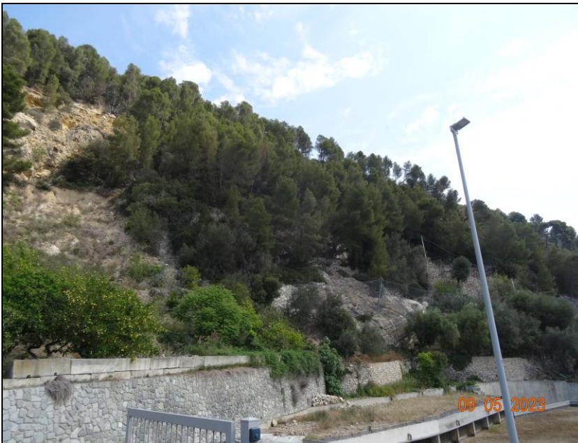
Figura 5: vista panoramica (da terra) del comparto di versante, zona est.
