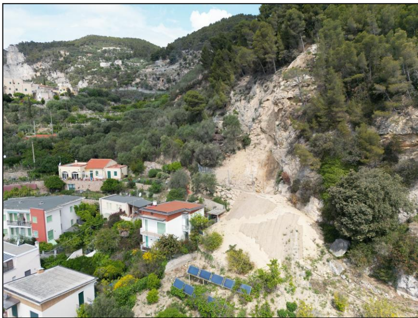
Figura 1: vista (da drone) della zona relativa al dissesto 2019 (area Pg4 del vigente PAI) e ben evidente il cantiere in corso d'opera.
