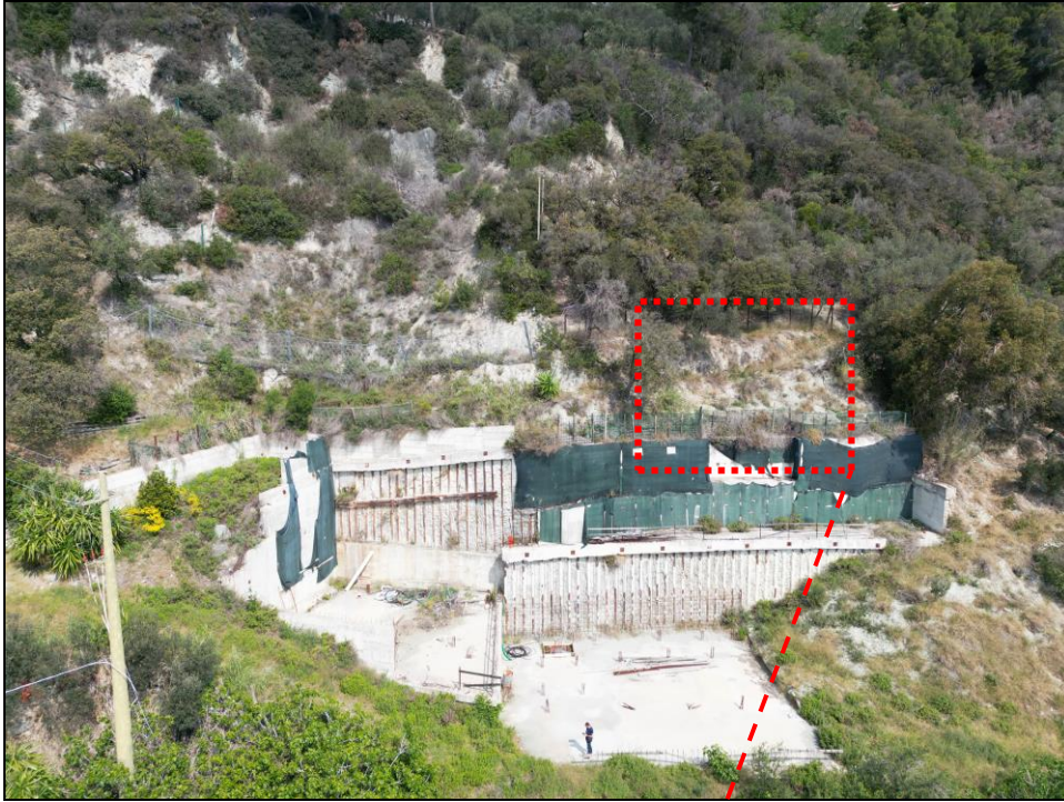
Figura 9 e 9bis: vista panoramica (da drone) dell'area di cantiere che riguardo il settore est mostra un minor grado di suscettività al dissesto rispetto al settore contiguo non risultando palesi elementi di pericolo pur permanendo uno scenario generale di fragilità idrogeologica. Il particolare mostra lo stato della vegetazione nelle immediate prossimità del fronte
