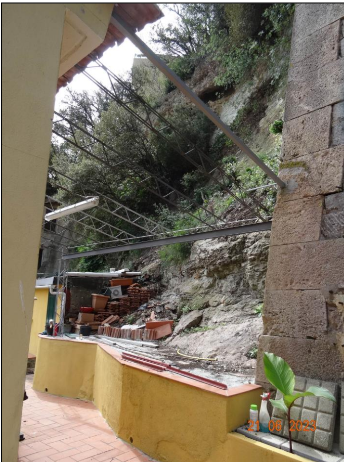
Figure 5: vista (da terra) dell'areale n.ro 2), si può osservare la relativa prossimità dell'edificio al fronte roccioso e l'assetto geologico dello stesso.
