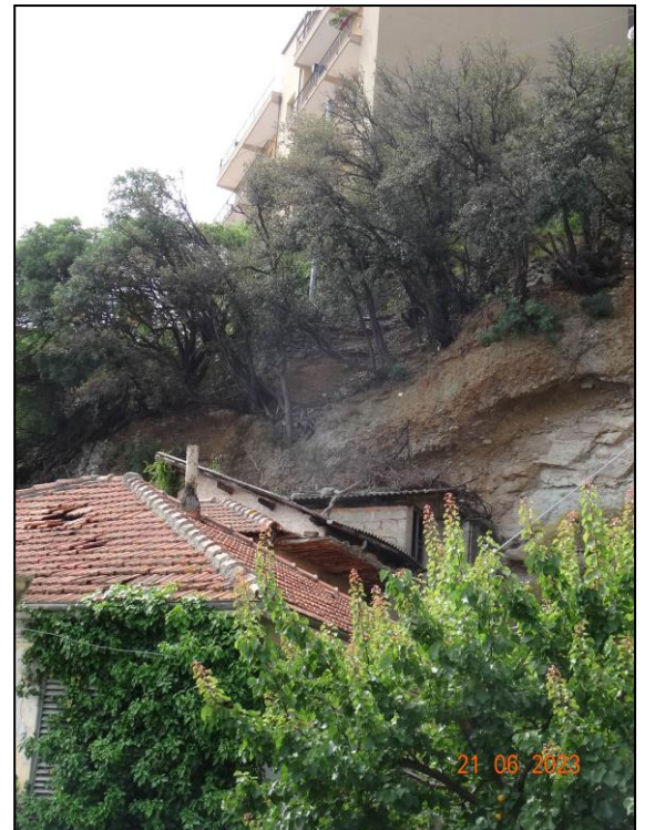
Figura 3 ter: vista (da terra) particolare della pendice sovrastante il fabbricato.
