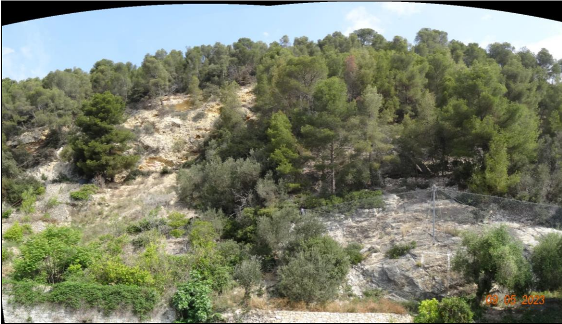
Figura 7: vista (da terra) settore est con evidenze del dissesto risalente al 2014, con presenza di fenomeni erosivi a carico sia del fronte residuale e delle zone boscate limitrofe.
