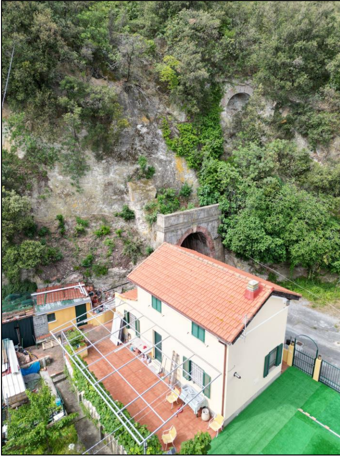
Figura 4: vista (da drone) dell'areale n.ro 2), si può osservare il rapporto geometrico intercorrente tra prospetto dell'edificio al fronte roccioso
