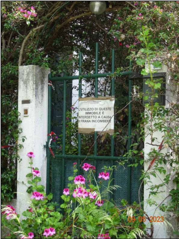
Figura 8: case inagibili sottostanti zona Pg4.
