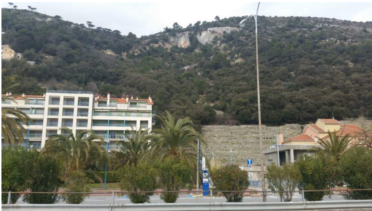
Vista panoramica del settore di versante sovrastante la Loc. Maremma in Comune di Spotorno (SV). Nella porzione superiore si possono osservare le pareti rocciose che costituiscono il "lato" di valle della trincea principale.
