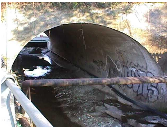
Figura 2.6.1.7 – Rio Coreallo: copertura attraversamento ferroviario
