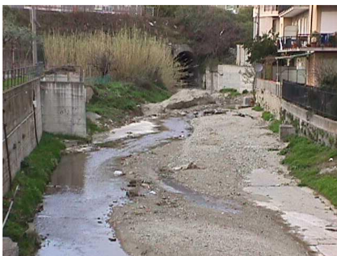
Figura 2.6.1.4: T. Crovetto – tratto tra l'attraversamento FFSS ed il ponte di Via Francia
