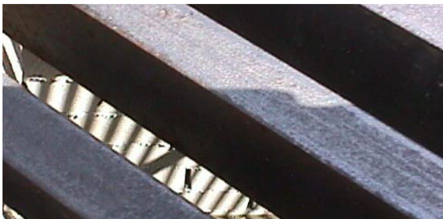
Figura 2.6.2.2.2 – Rio Nechiazze – Rio Laiolo: particolare dello scatolare in c.a. della copertura.
