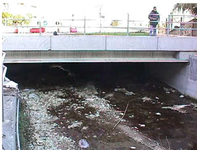
Figura 2.6.1.6: Rio Coreallo – imbocco copertura
