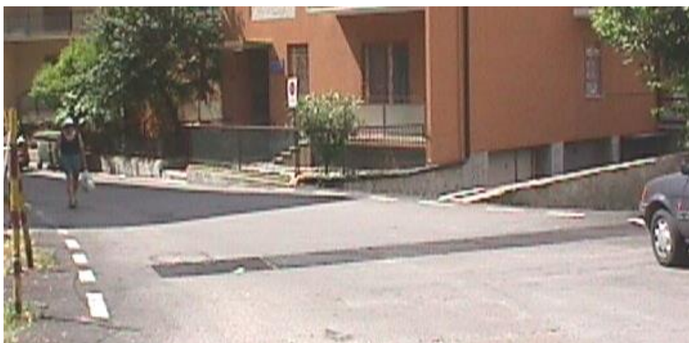
Figura 2.6.2. 2.1 – Rio Nechiazze – Rio Laiolo: griglia che segna l'inizio della copertura.
