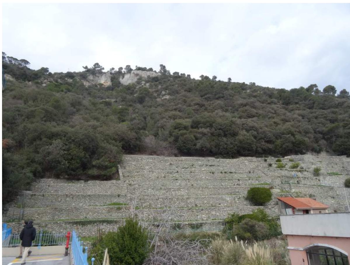
Vista panoramica del settore di piede del versante in Loc. Maremma in Comune di Spotorno (SV). Si osserva l'importante terrazzamento realizzato in fregio al fondovalle.
