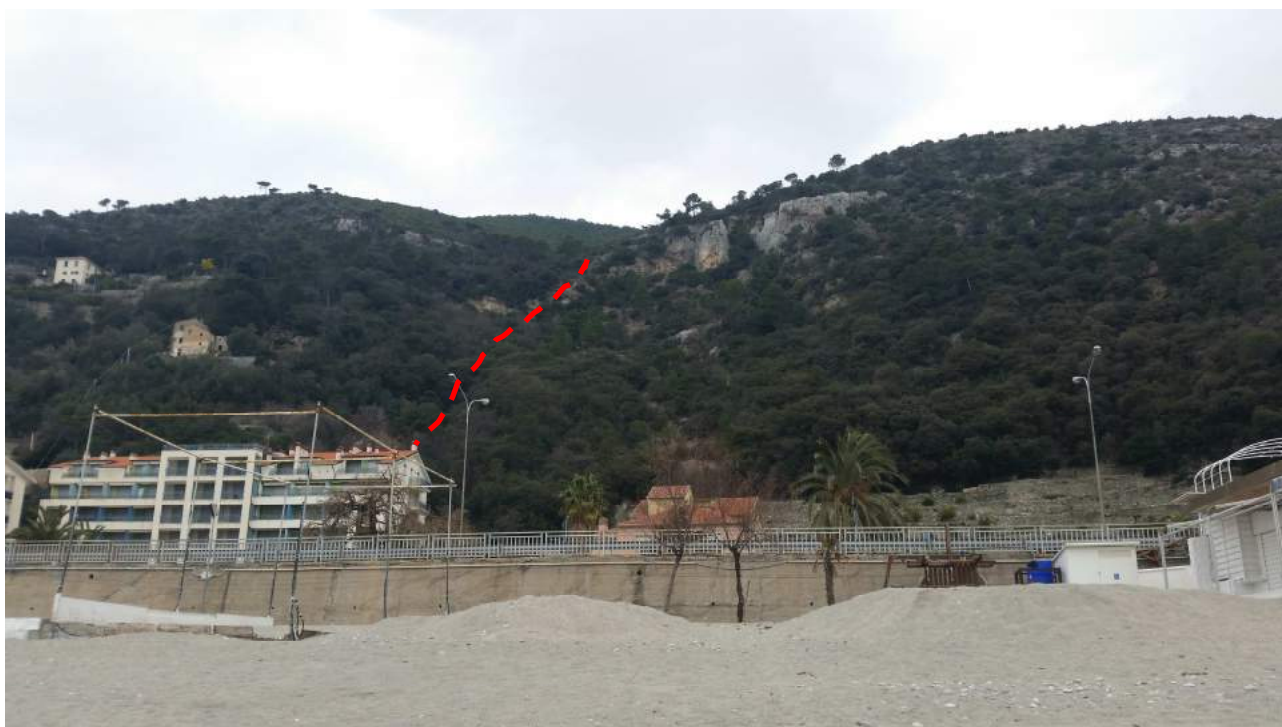
Vista panoramica della porzione di versante su cui insiste il bacino idrografico del Rio Maremma (traccia evidenziata con tratteggio).
