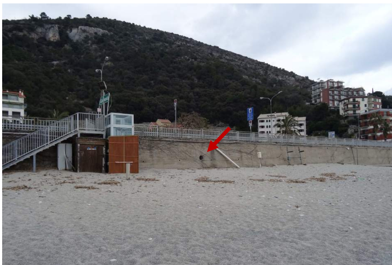
Vista dello sbocco della tombinatura del Rio Maremma presso la spiaggia (vedi freccia).
