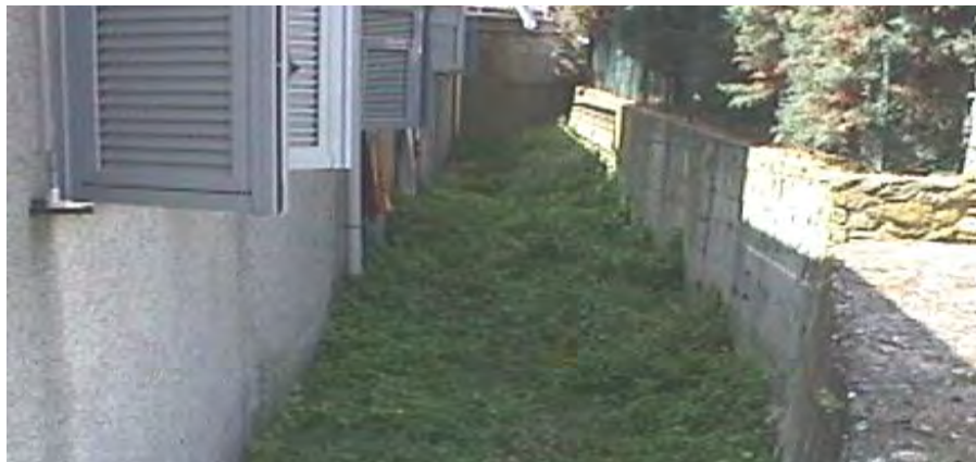
Figura 2.6.2.3.2 – Rio Chiariventi: situazione verso monte.
