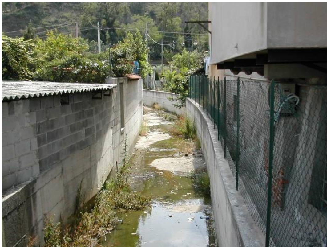
Rio S.Nicolò, tratto con arginatura inadeguata in sponda sinistra (destra rispetto all'immagine)
