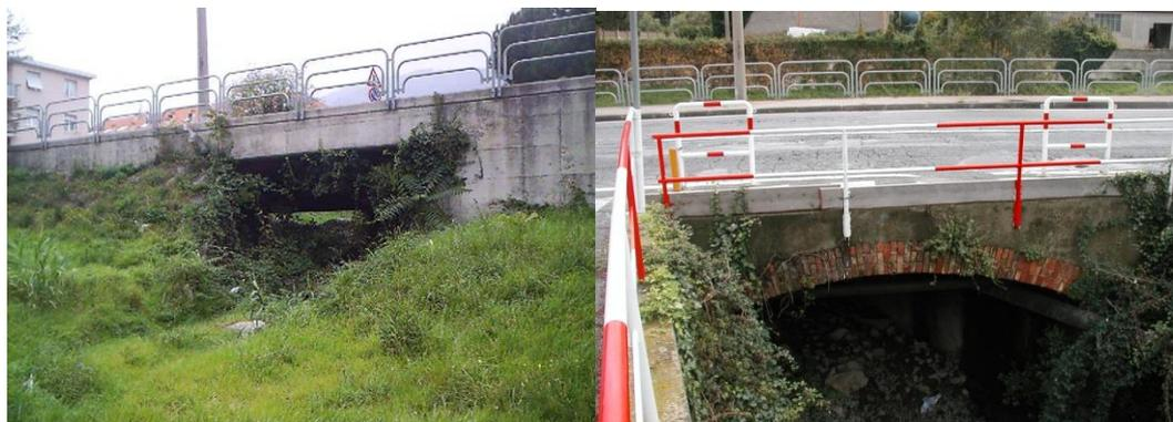
*Attraversamento di Via Piave alla confluenza con il T.Segno, con sezione di valle rettilinea (sez 1.2) e sezione a monte ad arco (sez 2)*
