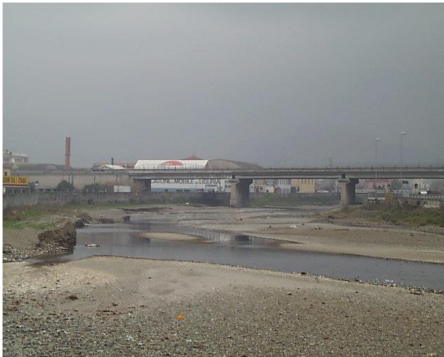
Ponte Autostrada Ge-XXmiglia da valle verso monte
