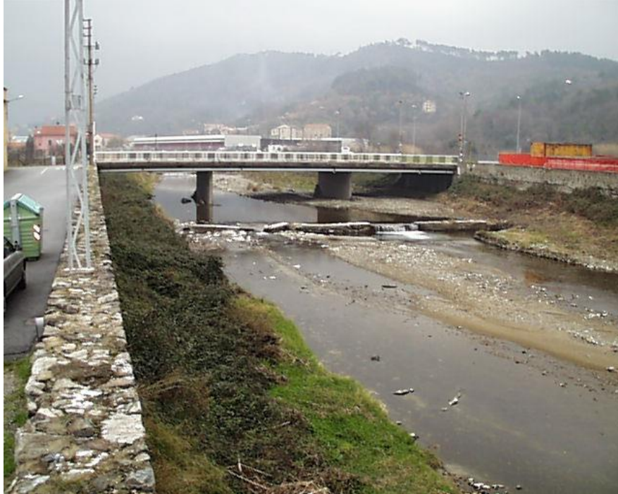
Ponte di Valleggia da valle verso monte
