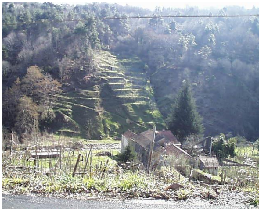
Corpo di frana riattivato in parte nel Gennaio 2001
