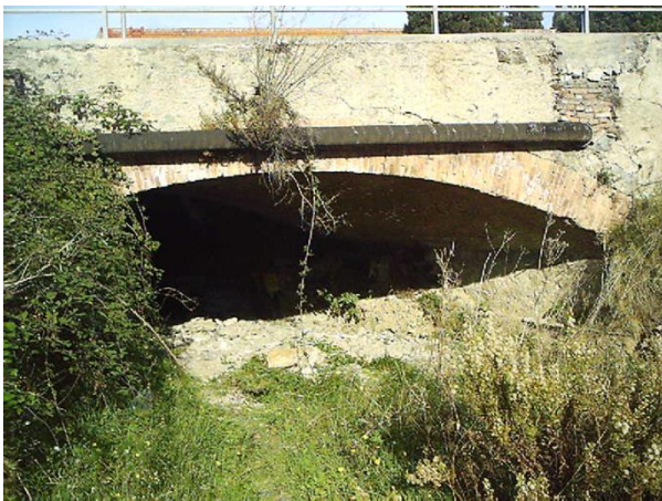
Ponte S.P. n. 29, con sezione di valle ad arco
