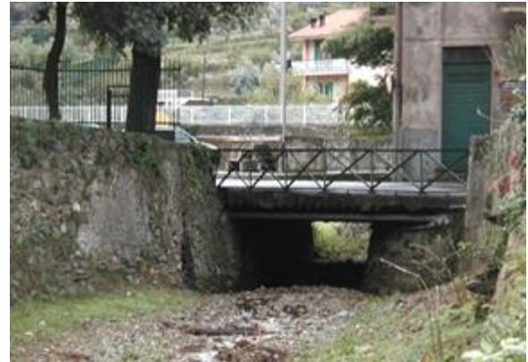
Sez 5: Ponte di Via Don Peluffò (sezione di monte)
