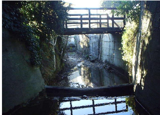
Sez. 13 da monte verso valle (briglia e passerella pedonale)
