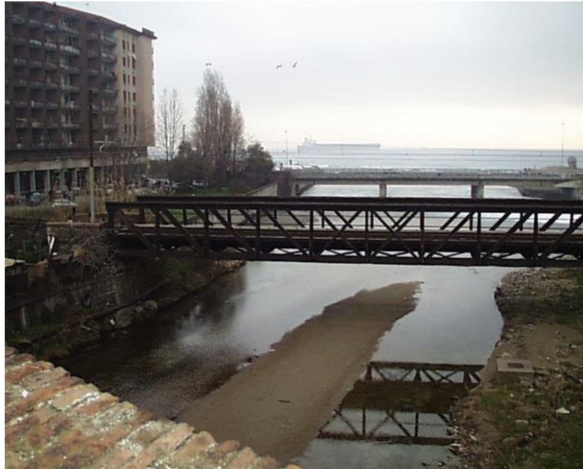
Ponte FS Savona-Vado da monte verso valle
