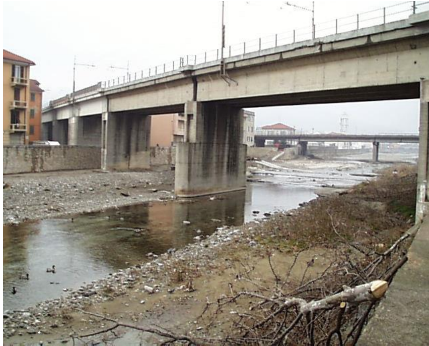
Particolare sulle pile in alveo del Ponte FS linea Ge-XXmiglia
