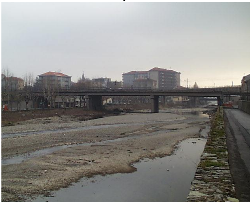
Ponte Strada di Scorrimento da monte verso valle
