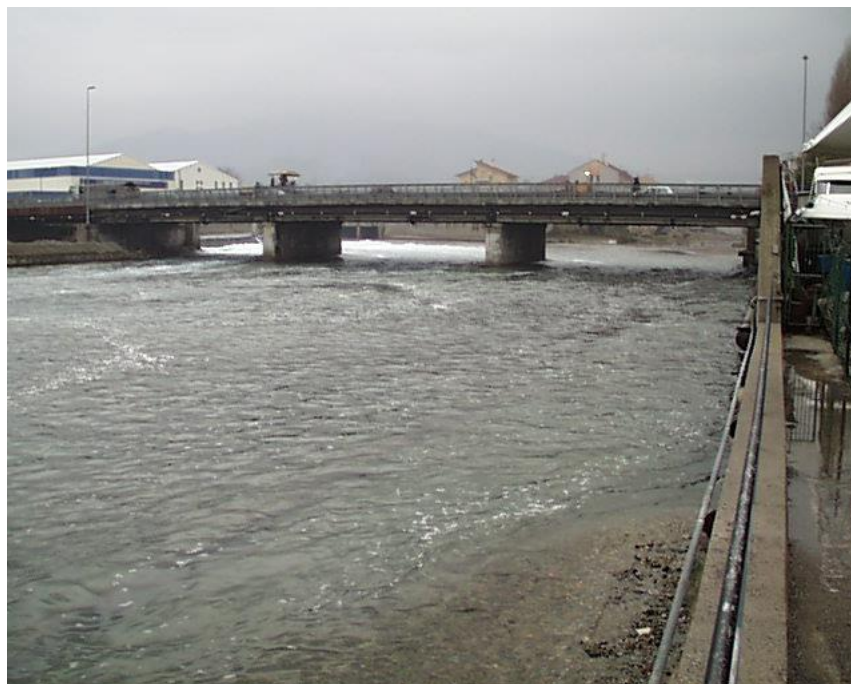
Ponte Aurelia da valle verso monte
